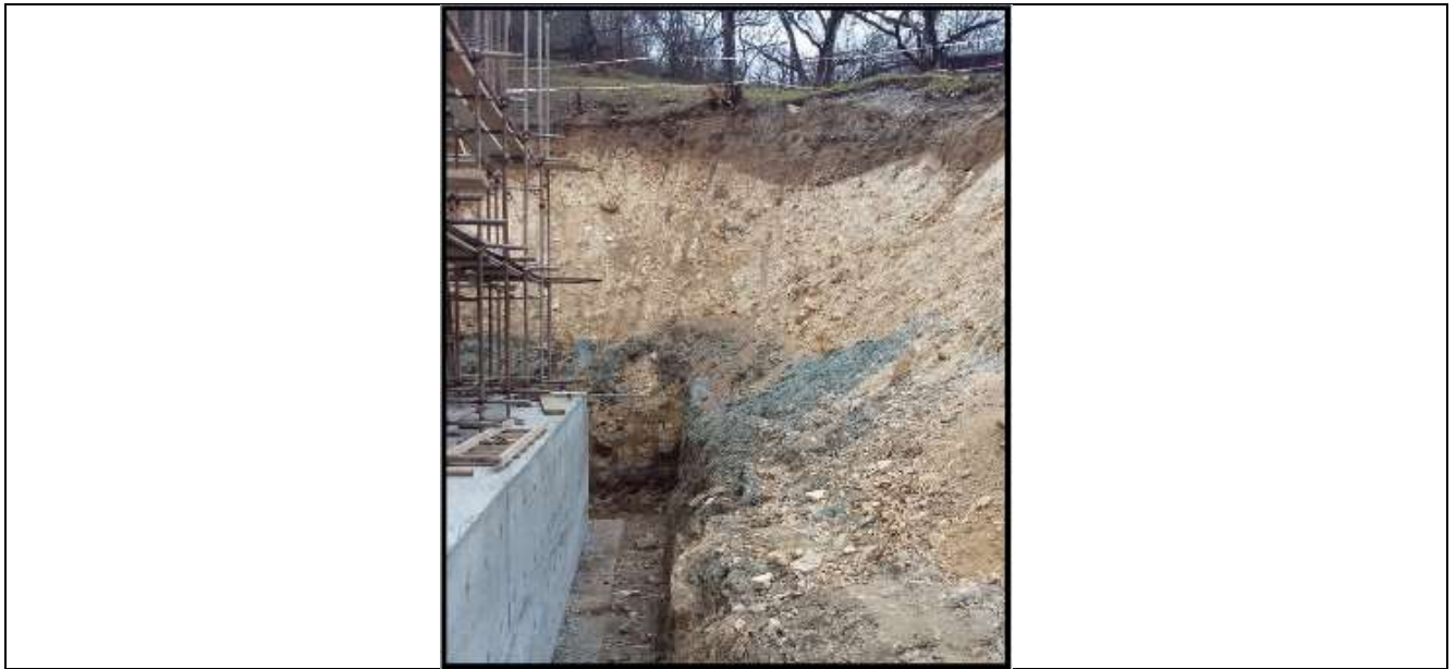
დაკვირვების წერტილი #12. გადასასვლელის საყრდენი, შეუკავშირებელი ღორღი და ხვინჭა თიხა-თიხნარიანი შემავსებლით
