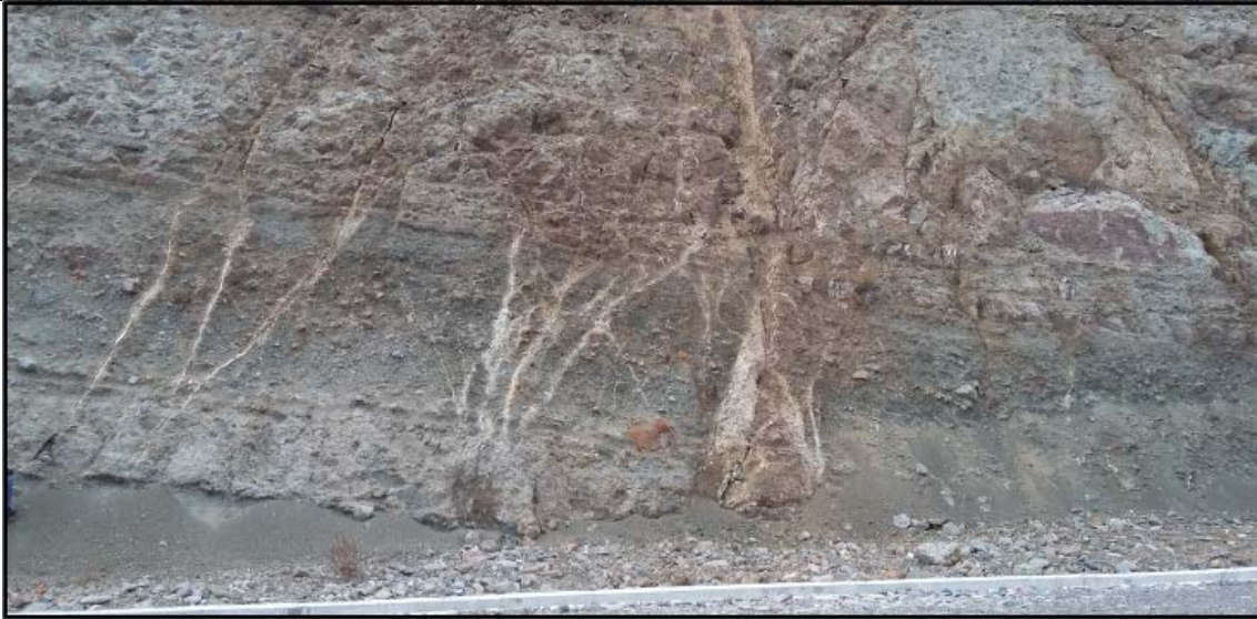
დაკვირვების წერტილი #4. სუბვერტიკალური ირიბი ბზარები, ამოვსებული მოყვითალო კალციტის მასით. თხელშრებრივი ტუფობრექციების სახესხვაობების ძირებთან წვრილმარცვლოვანი ნაცვენების დაგროვება.
