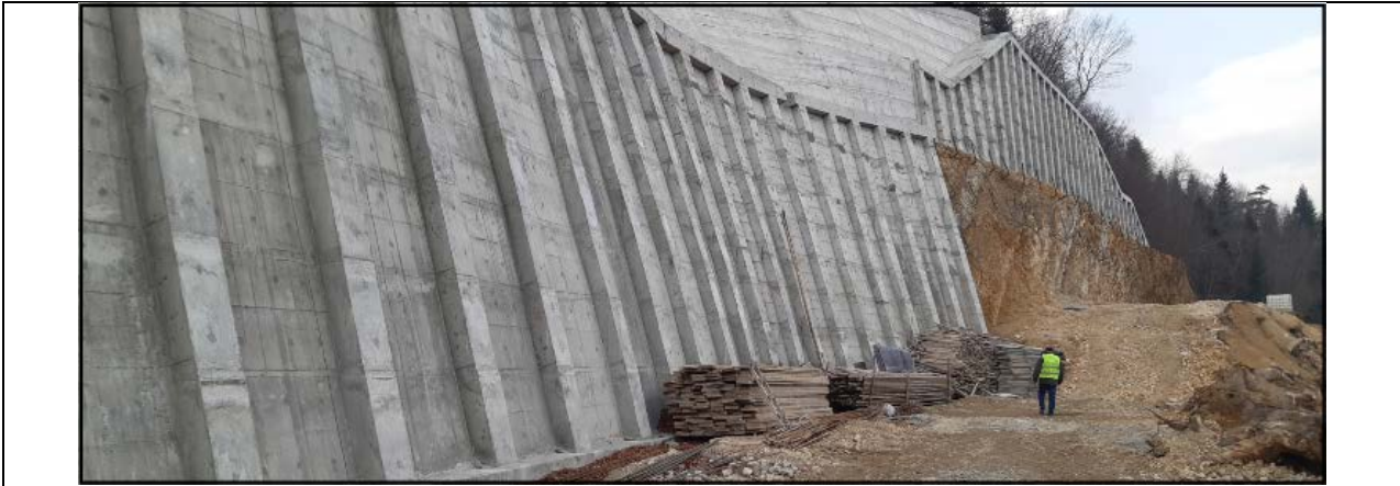
წერტილი #17.ციცაბოდ ჩამოჭრილი და ანკერირებული ბეტონით გამაგრებული ფერდი
