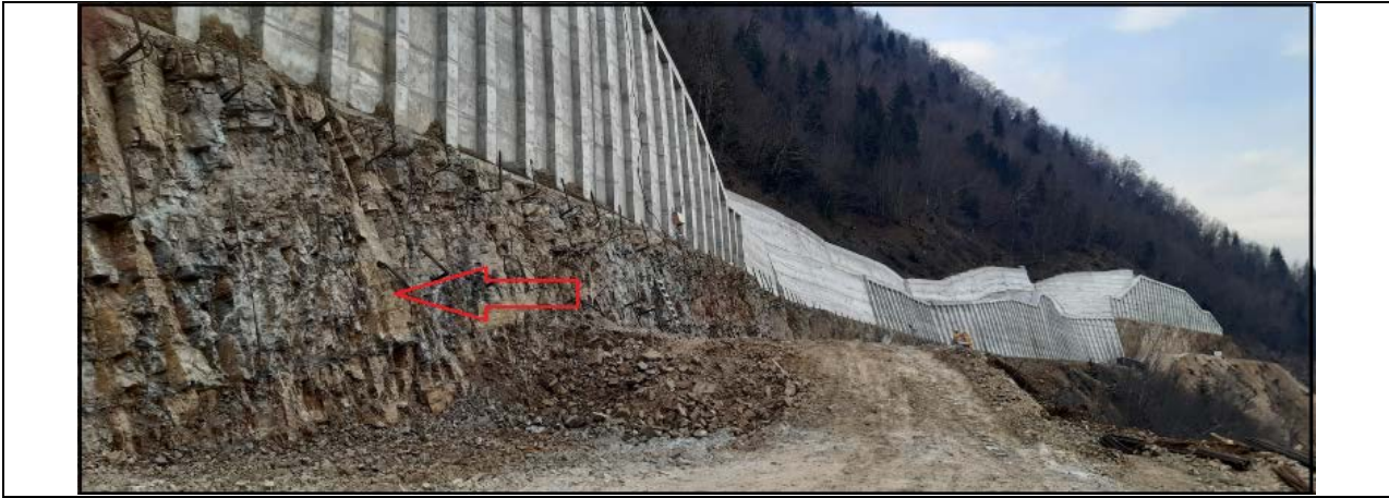
დაკვირვების წერტილი #19. ბეტონის ანკერირებული კედლის ორი რიგი და კარბონატული (მერგელოვანი) ქანების წყება (ასევე გამაგრდება ბეტონის კედლით).
