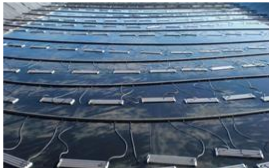
სურ. 3.1.6 - დასრულებული მიწური აუზის მშენებლობა დიფუზორის სისტემით (ნიმუში)
