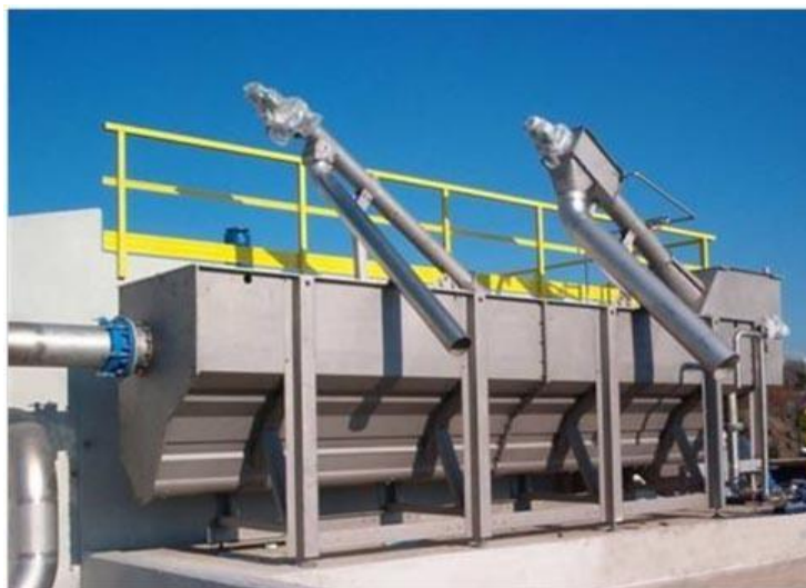
სურ. 7 - ტიპური კომბინირებული ცხაურის/ქვიშა/ცხიმის მოცილება
