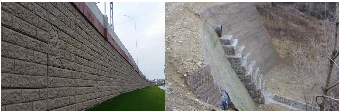
სურათი 3.14.1-1. ტიპური მექანიკურად სტაბილიზირებული გრუნტის კედლები
