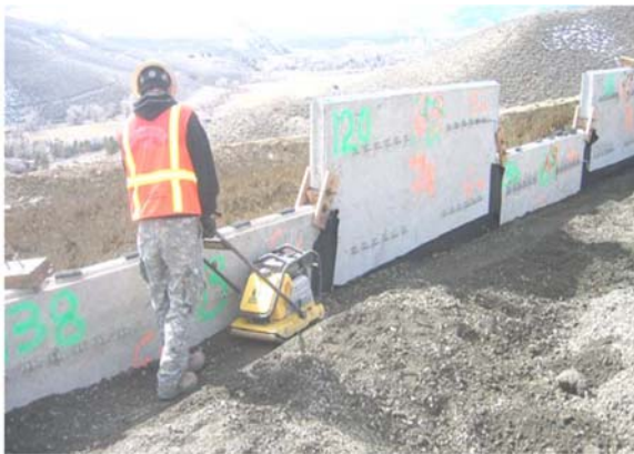
სურათი 3.14.5-1. მექანიკურად სტაბილიზირებული გრუნტის კედლების უკუშევისების მასალის დატკეპნის პროცესი
