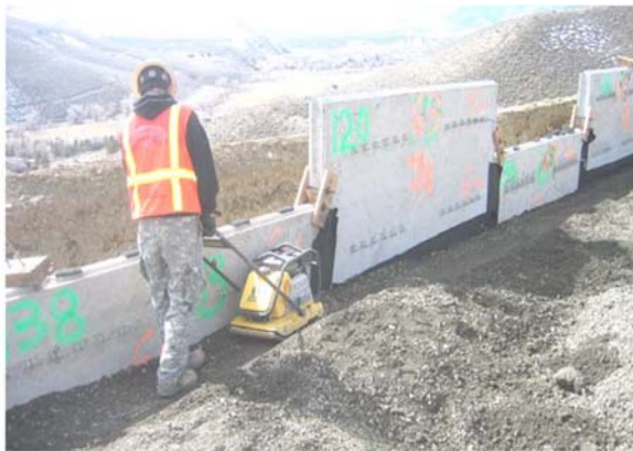
სურათი 4.14.5-1. მექანიკურად სტაბილიზირებული გრუნტის კედლების უკუშევსების მასალის დატკეპნის პროცესი
