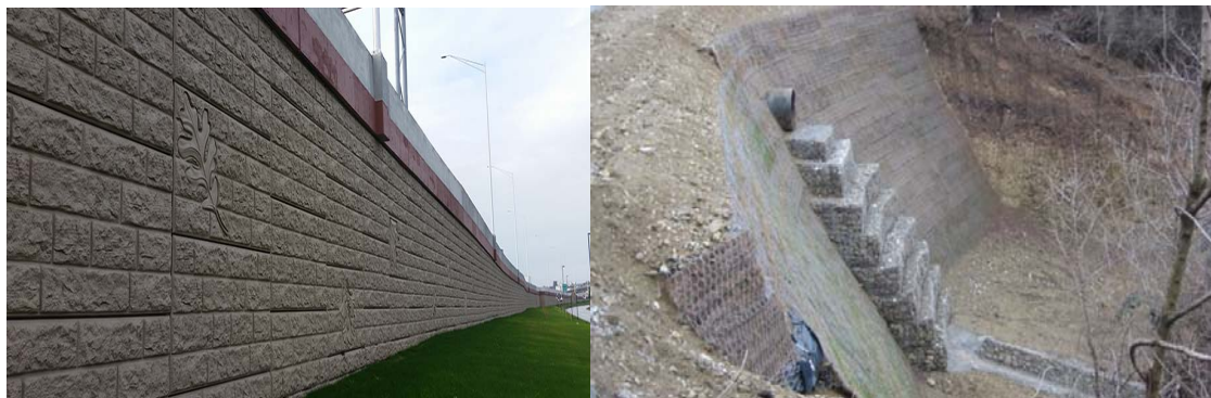
სურათი 4.14.1-1. ტიპური მექანიკურად სტაბილიზირებული გრუნტის კედლები
