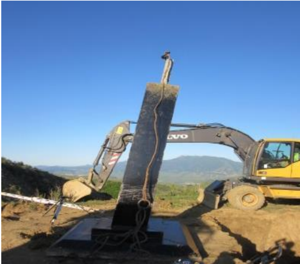
ნახ. 3.5.5 ტიპური წინასწარ ჩამოსხმული რკინა-ბეტონის საძირკველი
