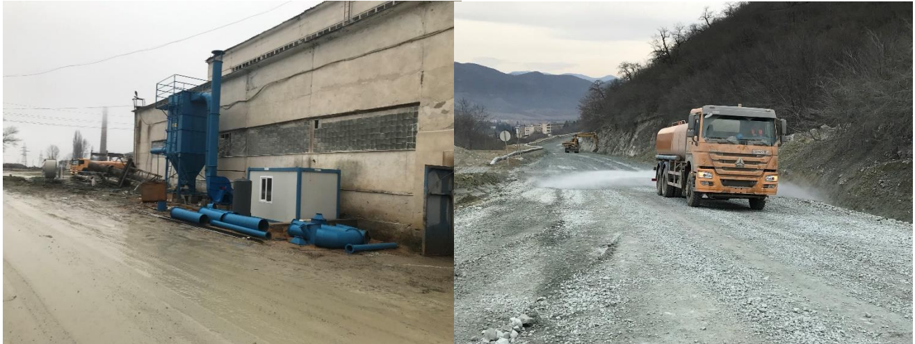
სურათი 5,6 მტვრის ემისიის შემცირება, ფილტრებიანი მტვერდამჭერი, გზების მორწყვა
