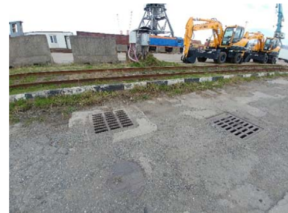
მე-6 ნავსადგომის ტერიტორია
