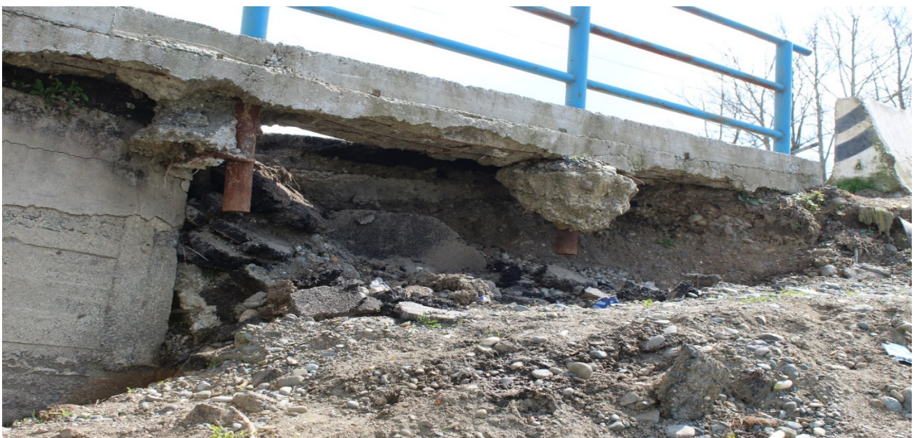
სურ 2 არსებლ ხიდზე დაფიქსირებული დაზიანებები
