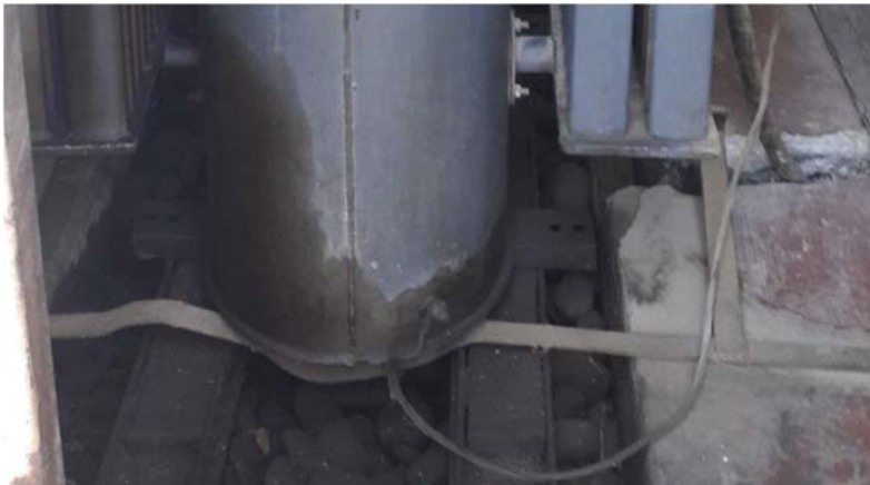
დახურულ შენობაში განთავსებული ტრანსფორმატორი, რომელიც დაბინძურებულია ზეთებით
