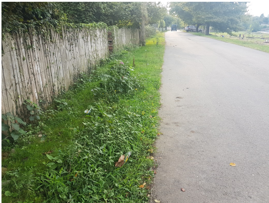
სურათი 5.3.1.3.5. მიწისქვეშა საკაბელო ხაზი, ჰაბიტატი - I რეგულარული ან ახლახან დამუშავებული სასოფლო-სამეურნეო მიწები, ბაღები და საკარმიდამო ნაკვეთები,
