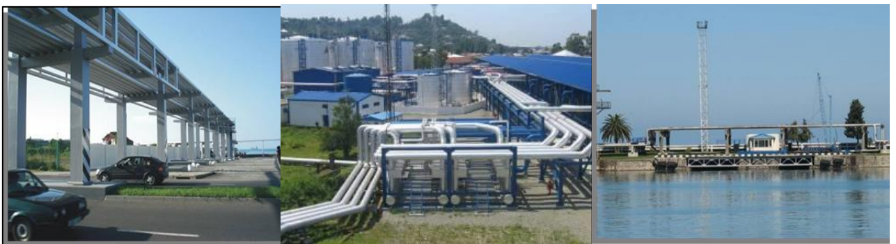
სურათი 4.2.3.3. ნავთობის და ნავთობპროდუქტების გადატვირთვის ტექნოლოგიური მილსადენები
