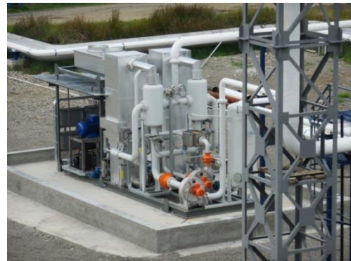
სურათი 6.4.1.2. აირგამწმენდი (აირების რეკუპერაციის) დანადგარი ნავთის უბანში
