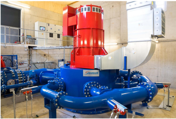
სურათი 3.4.3.1. რაჩხა ჰესისათვის შერჩეული პელტონის ტიპის ტურბინა
