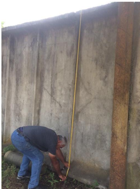
ღობე საწარმოო ტერიტორიის პერიმეტრზე
