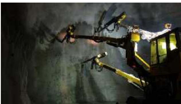
სურათი 3.1.2. ბურღვა საბურღი ურიკის გამოყენებით
