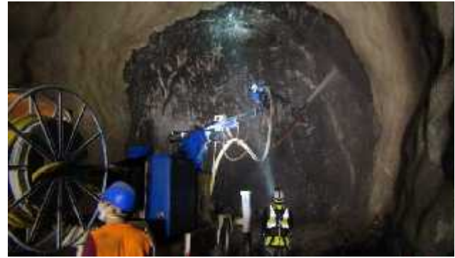
სურათი 3.1.5. ტორკრეტბეტონის მისხურება საბოლოო გამაგრებისთვის
