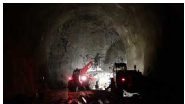
სურათი 3.1.3. ასაფეთქებელი მასალის შპურებში განთავსება
