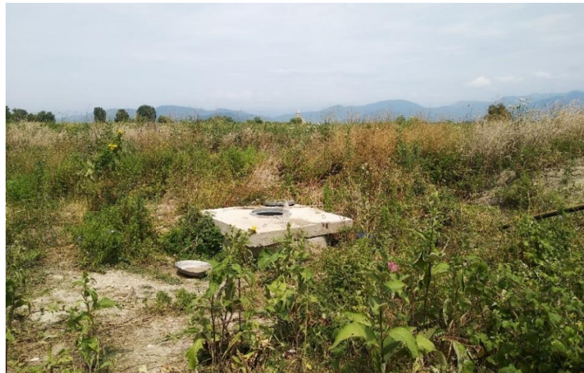
სურათი 2.2. სადრენაჟე გრუნტის წყლების შემკრები არსებული სისტემის მთავარი მაგისტრალის ერთ-ერთი ჭა
