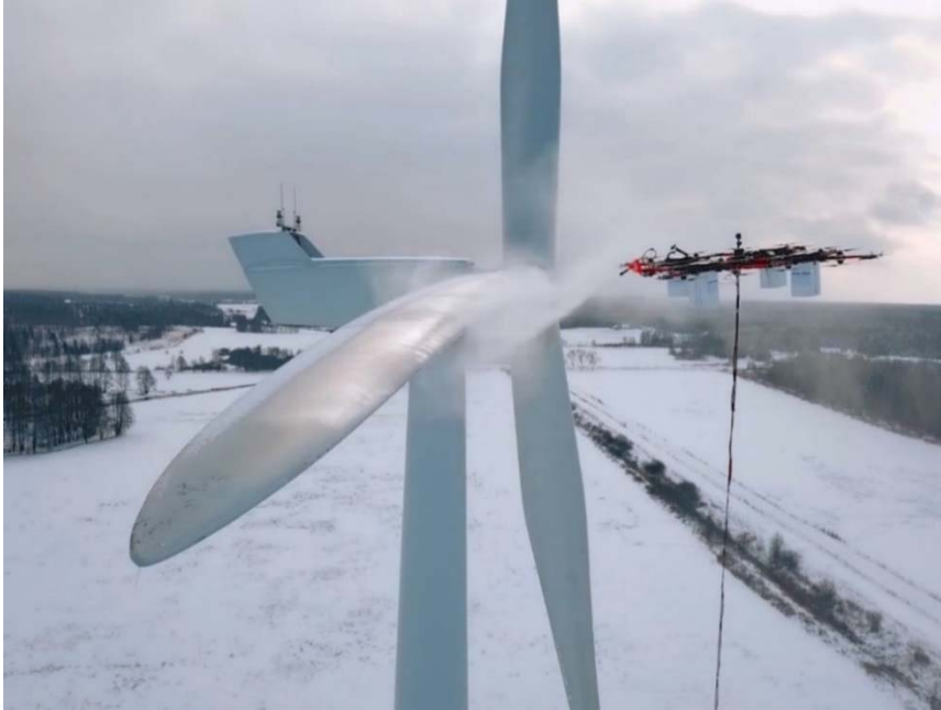
სურათი 6-12 დრონის გამოყენება ქარის ტურბინის გასაწმენდად
