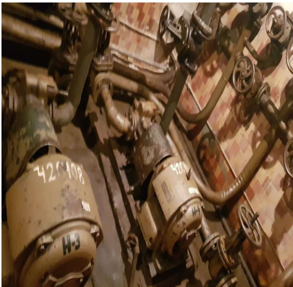
სურათი 4.1.5. ზეთების გადასატვირთი ტუმბოები
