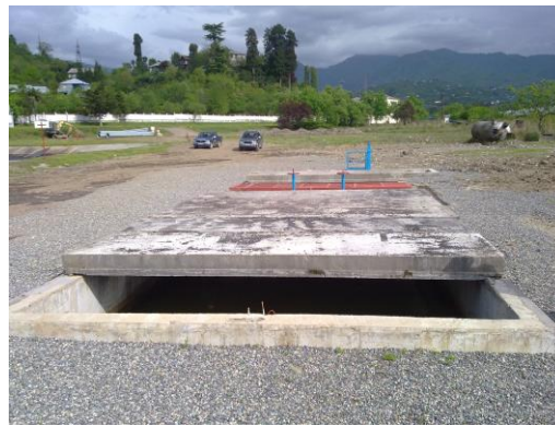
სურათი 4.2.3. „კაპრეშუმი“-ს უბნის №2 ნავთობდამჭერი (გეგმა)
