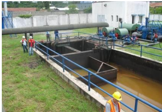
ნახაზი 4.6.2.4. ოთხკამერტიანი ნავთობდამჭერი N2 (ხედი)
