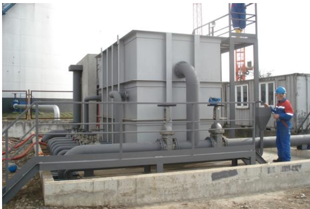
სურათი 4.1.5.5. ნავმისადგომების უბნის (ბალასტური და ლიალური წყლების) გამწმენდი ნაგებობებზე Facet Internationale-ს კოალესცენტური სეპარატორების ხედები
