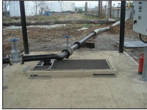
სურათი 4.5.3. ორი 20 000 მ 3 ტევადობის ნავთობის რეზერვუარების პარკის პირობითად სუფთა წვიმის წყლების გაყვანის სატუმბო სადგური და საწნეო მილსადენი
