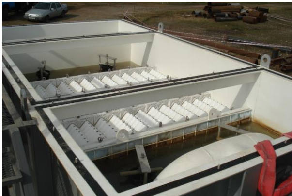
სურათი 4.1.5.6. ნავმისადგომების უბნის (ბალასტური და ლიალური წყლების) გამწმენდი ნაგებობების სეპარატორის კოალესცენტური ფირფიტები
