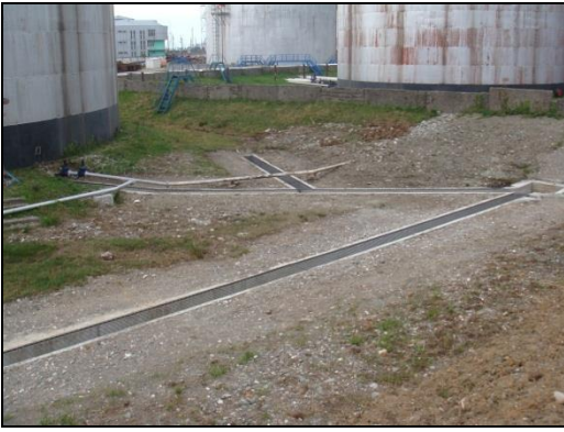
ნახაზი 4.1.1.2. ნავთის უბნის №№161, 162, 163, 164 რეზერვუარების პარკის საწარმოო-სანიაღვრო კანალიზაციის სისტემა
