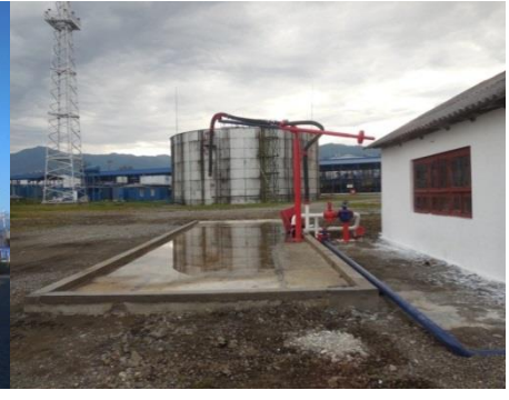
სურათი 3.3.4. ავტოცისტერნებში დიზელის საწვავის ჩასასხმელი დგარი
