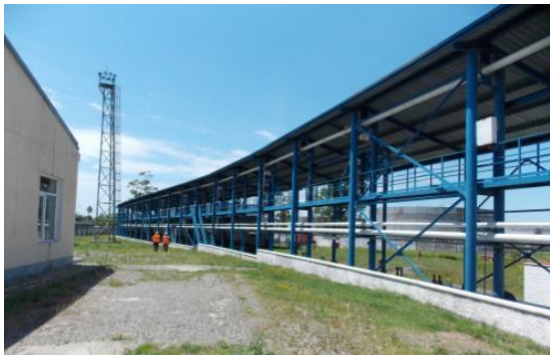
სურათი 3.6.2. ნავთობბაზის სარკინიგზო ესტაკადა და სავტომობილო ესტაკადა
