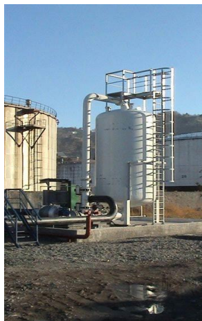
სურათი. 3.16.2.4. აირდამჭერი ფილტრი კაპრემუმის უბანში
