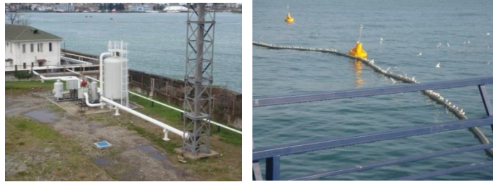
სურათი 3.16.2.2. აირგამწმენდი დანადგარი ნავმისადგომის უბანზე და უნაპირო ნავმისადგომიდან გაფრქვეული აირების გამყვანი მოტივტივე შლანგი
