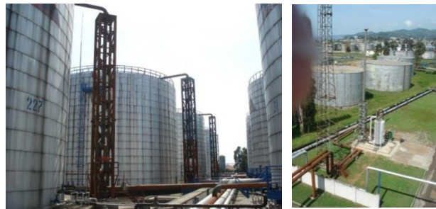
სურათი 3.16.2.3. №№ 224, 225, 226, 227, 228, 229, 230, 231, 236, 237 და 238 რეზერვუარების აირგამათანაბრებელი სისტემის და აირგამწმენდი ფილტრის საერთო ხედები
