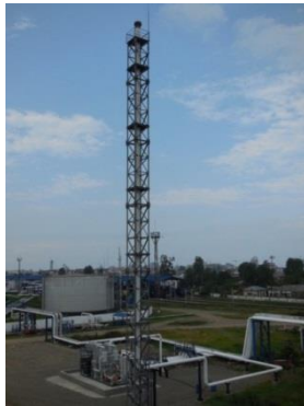
სურათი 3.16.2.6. აირგამწმენდი (აირების რეკუპერაციის) დანადგარი ნავთის უბანში
