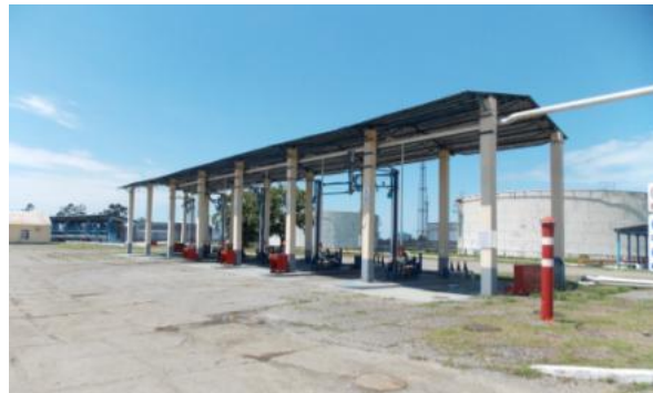
სურათი 3.6.2. ნავთობბაზის სარკინიგზო ესტაკადა და სავტომობილო ესტაკადა
