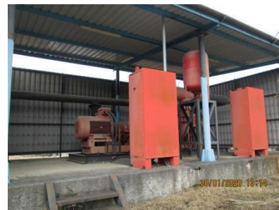
სურათი 3.16.1. სახანძრო წყლის მიწოდების სატუმბო სადგურები ძირითად ტერიტორიაზე და ხოლოდნაია სლობოდას უბანზე
