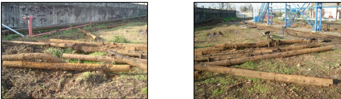
ძველი არაექსპლუატირებული მილების დემონტაჟი ნავთის უბანზე
