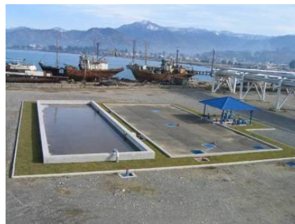
სურათი 7.1.6.4. ნავმისადგომების უბნის გამწმენდი ნაგებობების ლამშემკრები და ნავთობდამწვარი
