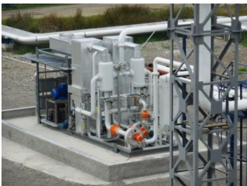
სურათი 13.5.9. აირგამწმენდი (აირების რეკუპერაციის) დანადგარი ნავთის უბანში
