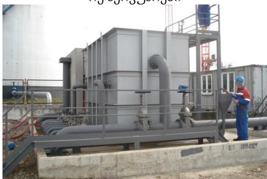
სურათი 7.1.6.5. ნავმისადგომების უბნის (ბალასტური და ლიალური წყლების) გამწმენდი ნაგებობებზე Facet Internationale-ს კოალესცენტური სეპარატორების ხედები
