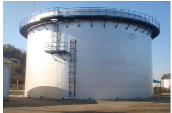
სურათი 5.9.1.4. გნა-ს მიღების და გადატვირთვის სადგურის არსებული ნავთობდამჭერი და 3000 მ 3 ტევადობის სახანძრო რეზერვუარი
