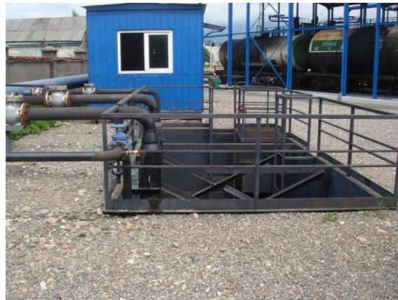
სურათი 7.4.2. #2 სარკინიგზო ესტაკადის სახურავიდან მონადენი წვიმის წყლების მდინარე ბარცხანაში გადასატუმბი სატუმბო სადგურის ხედი.
