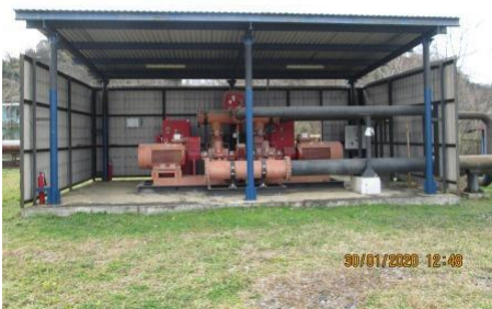
სურათი 12.2.1.2 . სახანძრო წყლის მიწოდების სატუმბო სადგურები თხევადი გაზის და კაპრემუმის უბნებზე
