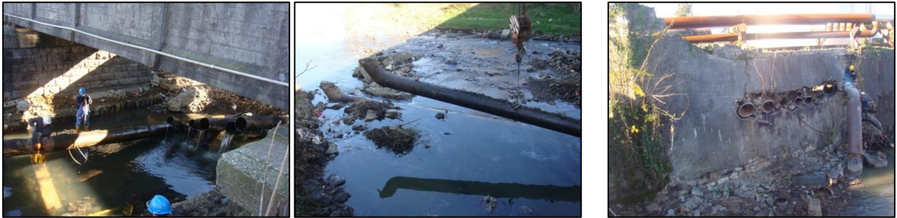
მიმდინარე ბარცხანას კალაპოტში არსებული მახლოკირებელი მილსადენების დემონტაჟის პროცესი
