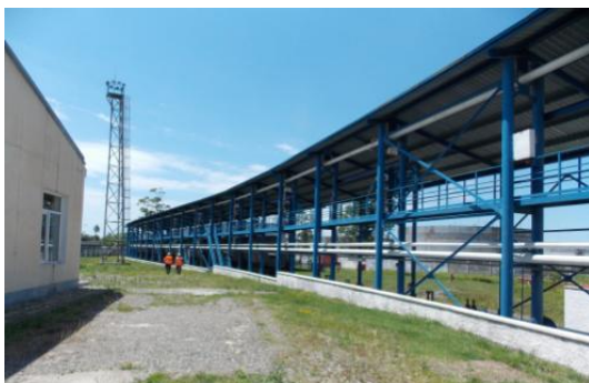
სურათი 5.7.2.1. ნავთობბაზის სარკინიგზო ესტაკადა და საავტომობილო ესტაკადა
