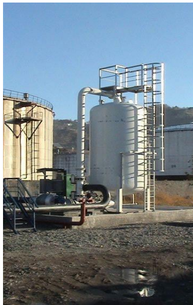
სურათი. 13.5.6. აირდამჭერი ფილტრი კაპრემუმის უბანში
