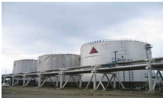
სურათი 7.1.6.3. ნავმისადგომების უბნის გამწმენდი ნაგებობების ბუფერული რეზერვუარები
