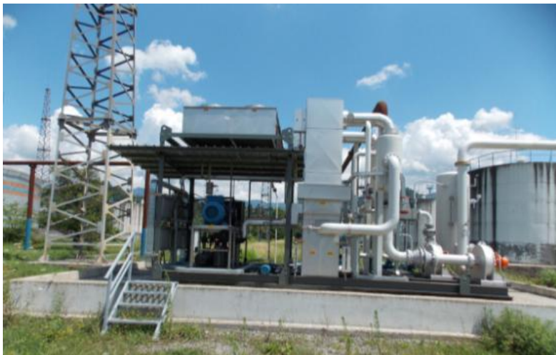
სურათი 13.5.7. ნავთობბაზის ნახშირწყალბადოვანი აირების სარეკუპერაციო დანადგარი
