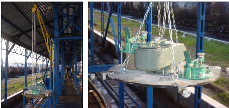
სურათი 13.5.1. ჰერმეტიზაციის საარქველები № 5 სარკინიგზო ესტაკადაზე
