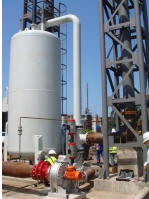
სურათი 13.5.5. აირგამწმენდი ფილტრი „ნედლი ნავთობისა და მაზუთის“ უბანში
