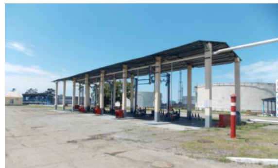
სურათი 5.7.2.1. ნავთობბაზის სარკინიგზო ესტაკადა და საავტომობილო ესტაკადა
