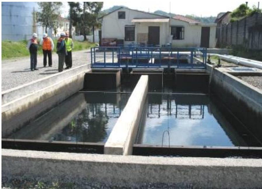
სურათი 7.1.3.2. დიზელის უბნის ნავთობდამჭერი
