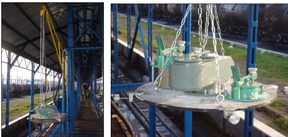
სურათი 16.11.1. ჰერმეტიზაციის სარქველები № 5 სარკინიგზო ესტაკადაზე
