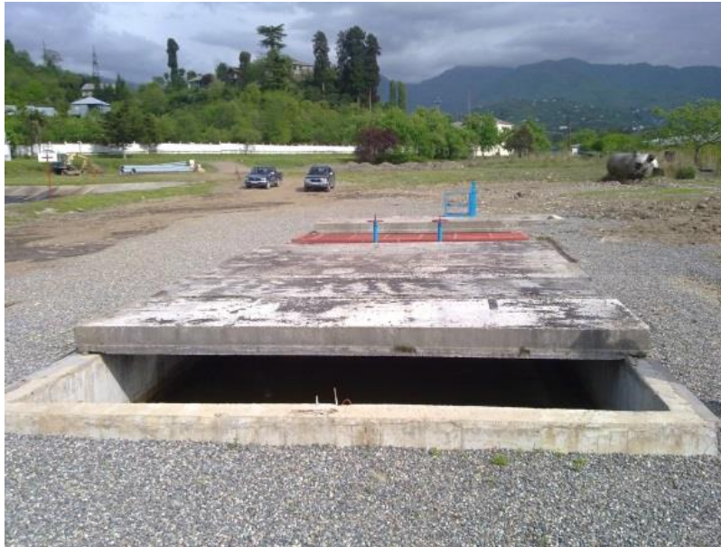
სურათი 7.2.3. „კაპრემუმი“-ს უბნის №2 ნავთობდამჭერის ხედი
