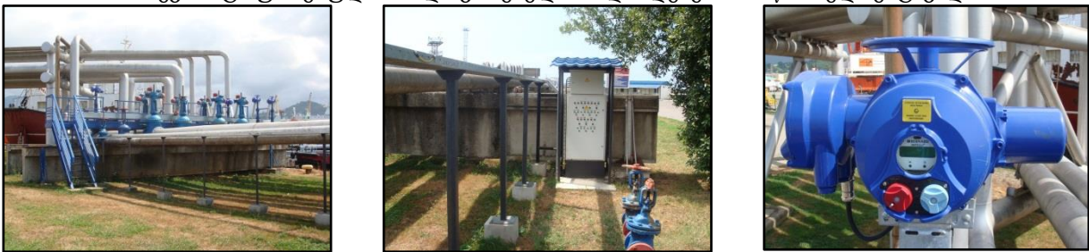
ახალი ჩამკეტ-მარეგულირებელი არმატურა (საკვალთები) მახლოკირებელ მილსადენებზე
