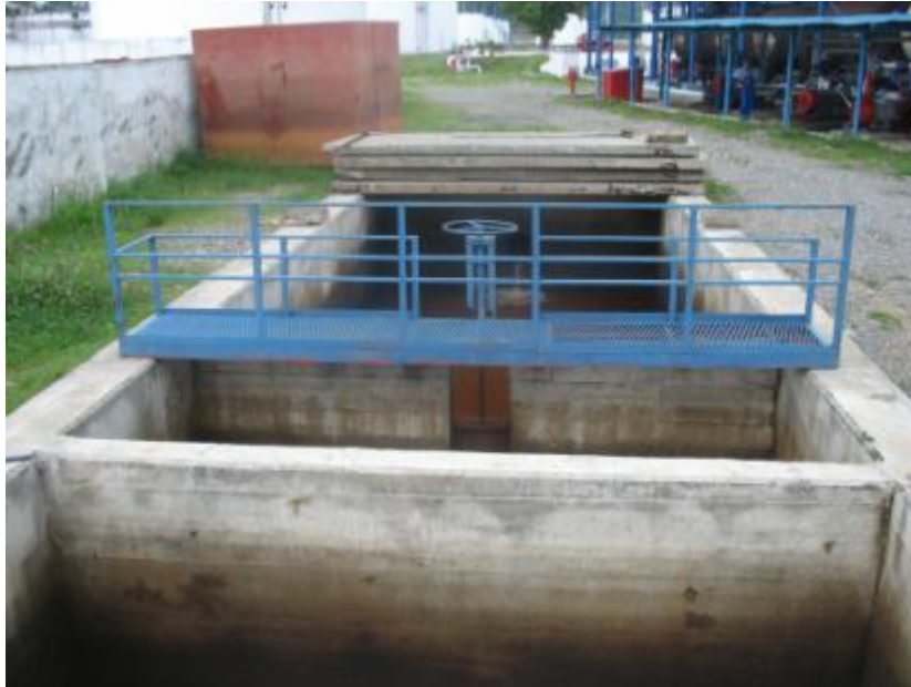
სურათი 7.6.1.3. ნავთობბაზის ლოკალური ნავთობდამჭერის ხედი
