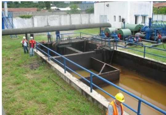
სურათი 7.6.2.2. ოთხკამერიანი ნავთობდამჭერი N2 (ხედი)
