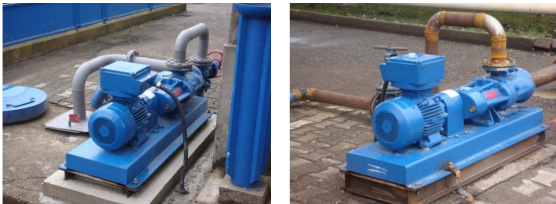
სურათი 7.1.6.1. ჩამდინარე წყლების მიმღები ჭები და გადასატუმბი დანადგარები №2 და №3 ნავმისადგომებზე
