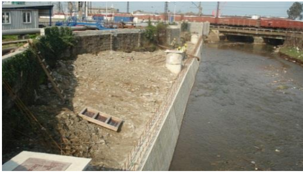
სურათი 9.2. გრუნტის წყლების სადრენაჟო სისტემა ძირითად ტერიტორიაზე მდ ბარცხანას გასწვრივ და კაპრეშუმის უბანზე მდ. ყოროლისწყლის გასწვრივ
