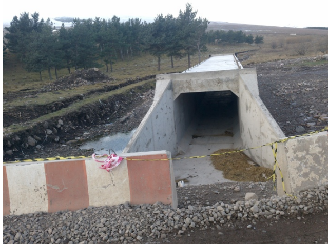
ნახაზი 31. ტიპური წყალმიმღები და წყალსაშვი ნაგებობები
