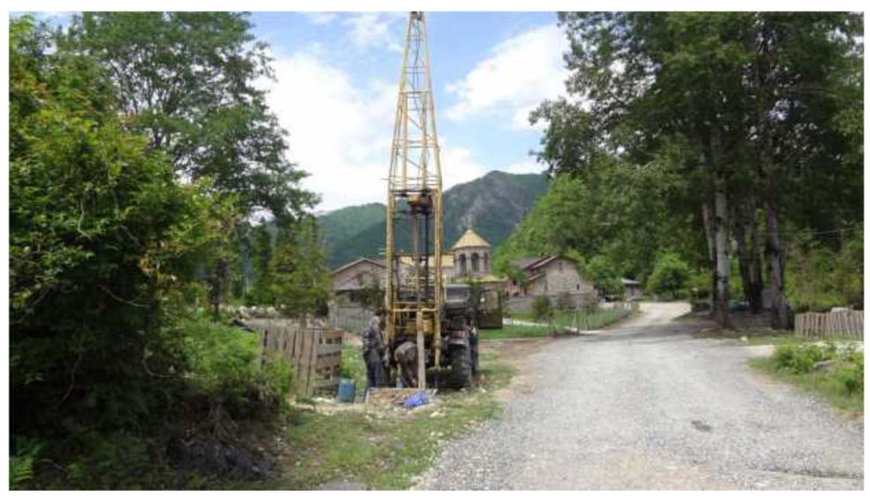
№ 17 ჭაბურღილის ბურღვის პროცესი, ხედი ჩრდილოეთით წინა პლანზე მოჩანს ახლადამენებული სამონასტრო კომპლექსის ხედი
