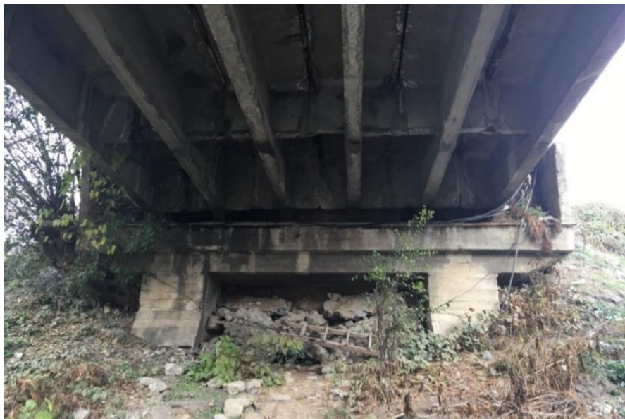
სურ. 5.1.2 - არსებული ხიდის ამორტიზირებული სტრუქტურა
