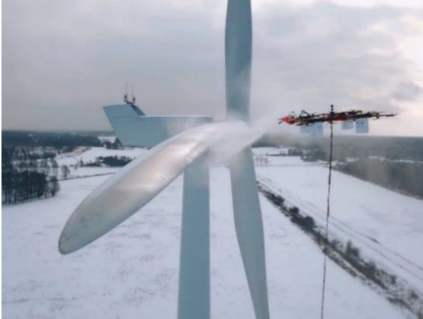
სურათი 6-46 დრონის გამოყენება ქარის ტურბინის გასაწმენდად
