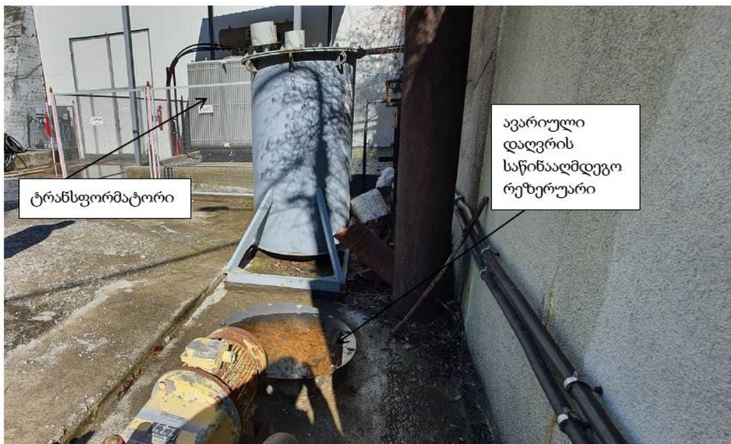
სურათი 2.2.2. ტრანსფორმატორი და დაღვრის საწინააღმდეგო რეზერვუარი
