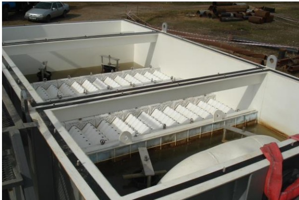
სურათი 5.1.6.6. ნავმისადგომების უბნის (ბალასტური და ლიალური წყლების) გამწმენდი ნაგებობების სეპარატორის კოალესცენტური ფირფიტები
