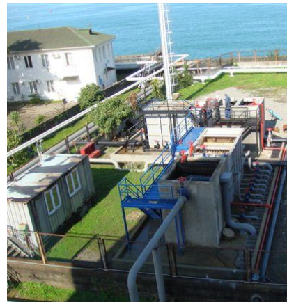
სურათი 5.1.6.5. ნავმისადგომების უბნის (ბალასტური და ლიალური წყლების) გამწმენდი ნაგებობებზე Facet Internationale-ს კოალესცენტური სეპარატორების ხედები
