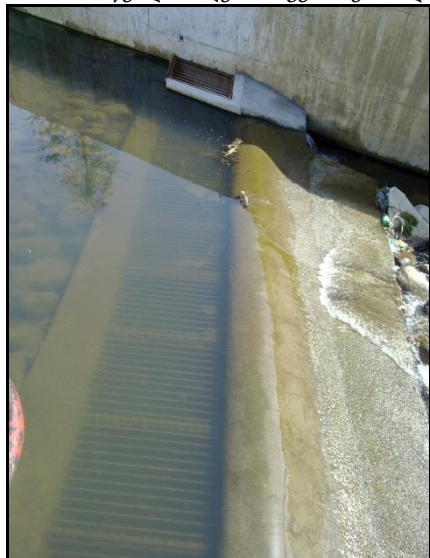
ნახ. 4.2.1. წყალმიმღები ნაგებობები მდინარე კუბასწყალზე
