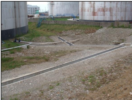
ნახაზი 5.1.2.1. ნავთის უბნის №№161, 162, 163, 164 რეზერვუარების პარკის საწარმოო-სანიაღვრო კანალიზაციის სისტემა
