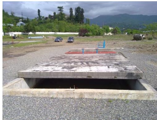
სურათი 5.2.3. „კაპრეშუმი“-ს უბნის №2 ნავთობდამჭერი (გეგმა)
