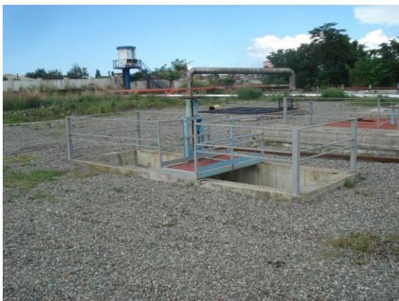
ნახაზი 5.2.7. კაპრეშუმის უბნის საწარმო-სანიაღვრო ჩამდინარე წყლების გაწმენდის #2 და #3 ნავთობდამჭერების ხედი
