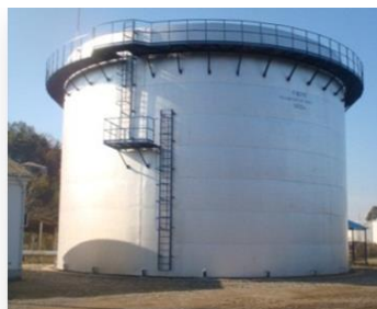
სურათი 3.2.1.4. გნა-ს მიღების და გადატვირთვის სადგურის არსებული ნავთობდამჭერი და 3000 მ3 ტევადობის სახანძრო რეზერვუარი
