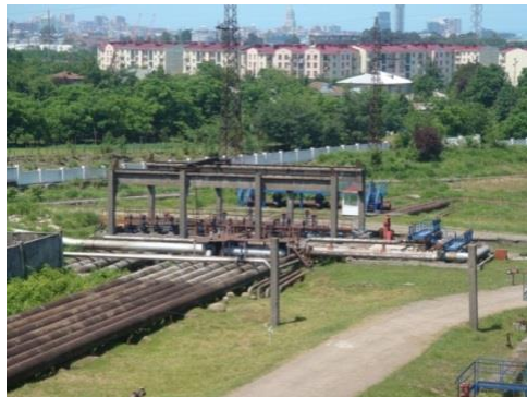
სურათი 5.6.4. ნედი ნავთობის მიღების და გადატვირთვის სადგური - „კაპრეშუმის“ ტექნოლოგიური მილსადენები, მთავარი მანიფოლდი, და სატუმბო სადგურის შენობა
