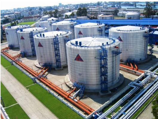
ახალი რეზერვუარები ძირითად უბანზე
