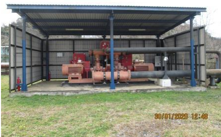
სურათი 12.2.1.2. სახანძრო წყლის მიწოდების სატუმბო სადგურები თხევადი გაზის და კაპრემუმის უბნებზე
