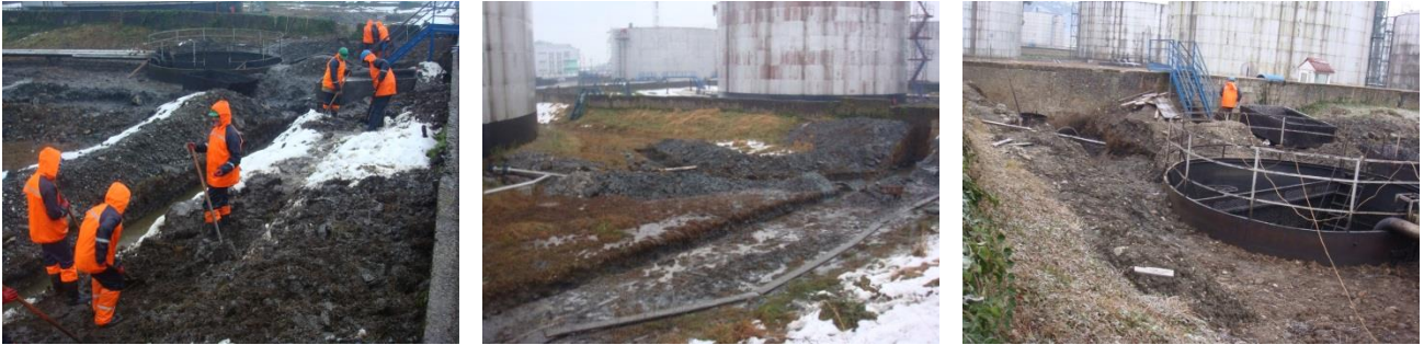
სარეზერვუარო პარკების შიდა ტერიტორიებზე ეკოლოგიური რეაბილიტაციის სამუშაოების მიმდინარეობა
