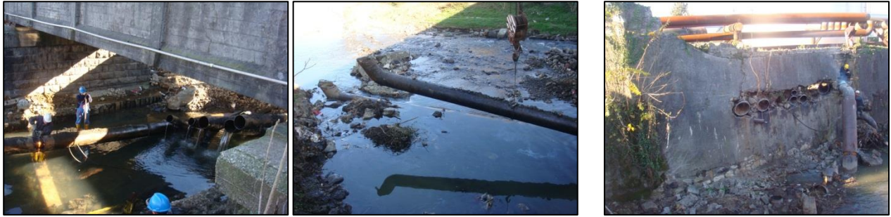
მდინარე ბარცხანას კალაპოტში არსებული მახლოკირებელი მილსადენების დემონტაჟის პროცესი
