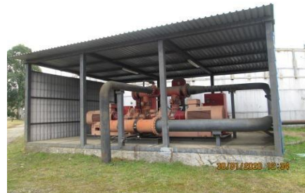
სურათი 12.2.1.1. სახანძრო წყლის მიწოდების სატუმბო სადგურები ძირითად ტერიტორიაზე და ხოლოდნაია სლობოდას უბანზე
