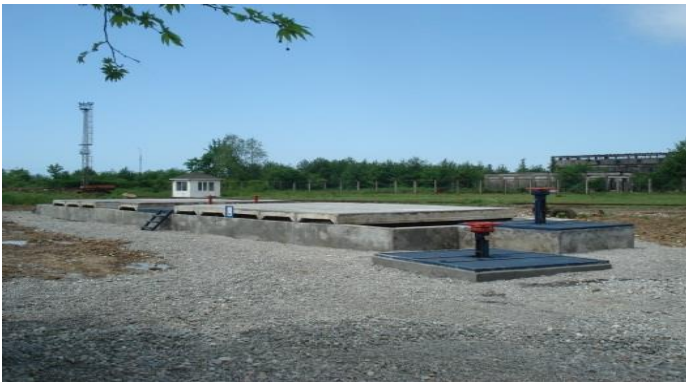
სურათი 5.9.1.4. გნა-ს მიღების და გადატვირთვის სადგურის არსებული ნავთობდამჭერი და 3000 მ 3 ტევადობის სახანძრო რეზერვუარი
