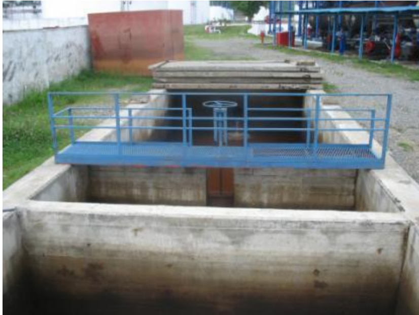
სურათი 7.6.1.3. ნავთობაზის ლოკალური ნავთობდამჭერის ხედი
