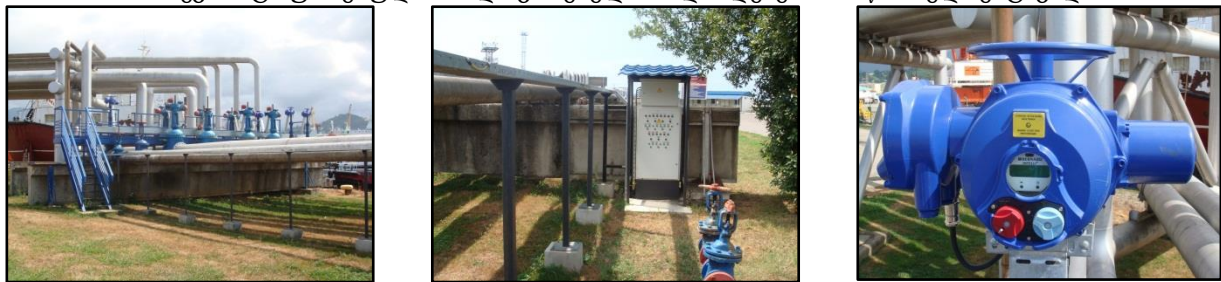
რეკონსტრუირებული მახლოკირებელი მილსადენების მიწისზედა ესტაკადა
