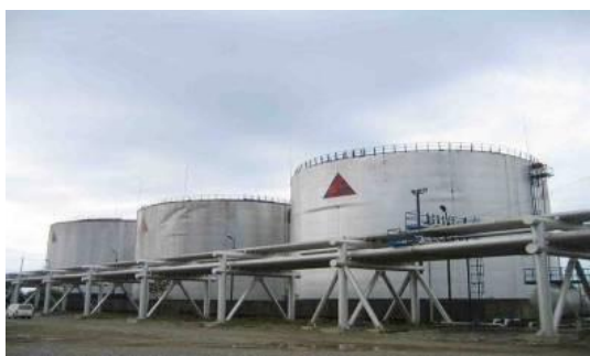
სურათი 7.1.6.3. ნავმისადგომების უბნის გამწმენდი ნაგებობების ბუფერული რეზერვუარები
