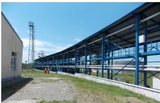
სურათი 5.7.2.1. ნავთობბაზის სარკინიგზო ესტაკადა და საავტომობილო ესტაკადა
