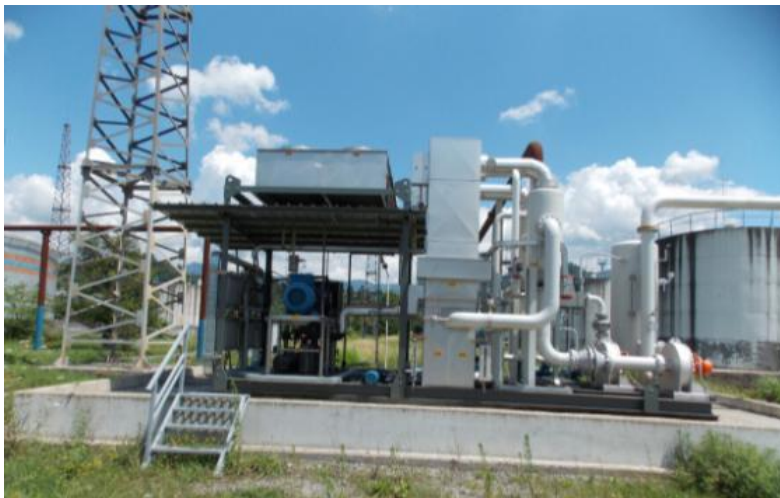
სურათი 13.5.7. ნავთობბაზის ნახშირწყალბადოვანი აირების სარეკუპერაციო დანადგარი
