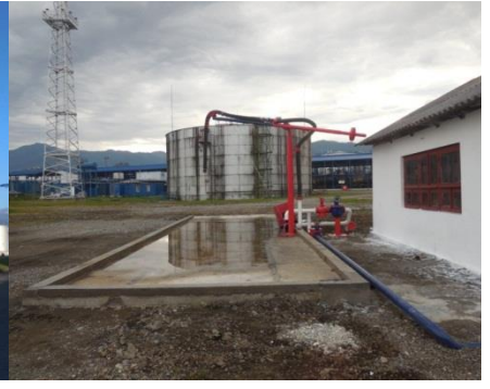
სურათი 5.4.4.3. ავტოცისტერნებში დიზელის საწვავის ჩასასხმელი დგარი
