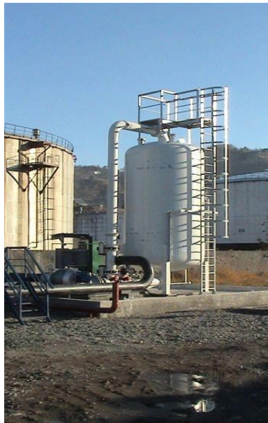
სურათი. 13.5.6. აირდამჭერი ფილტრი კაპრემუმის უბანში
