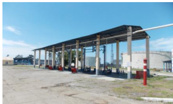
სურათი 5.7.2.1. ნავთობბაზის სარკინიგზო ესტაკადა და საავტომობილო ესტაკადა
