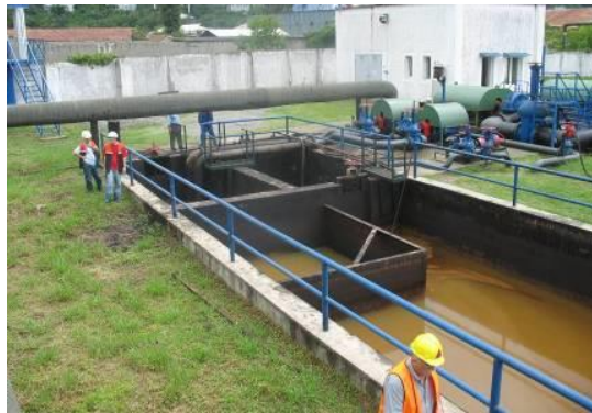
სურათი 7.6.2.2. ოთხკამერიანი ნავთობდამჭერი N2 (ხედი)
