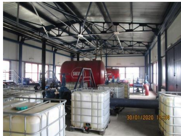
სურათი 12.2.2.1. ხანძარქრობის ქაფის და გასაგრილებელი წყლის ავტომატიზირებული სატუმბო სადგური
