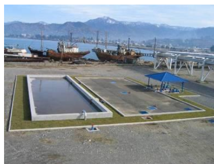
სურათი 7.1.6.4. ნავმისადგომების უბნის გამწმენდი ნაგებობების ლამშემკრები და ნავთობდამჭერი
