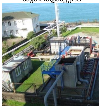
სურათი 7.1.6.5. ნავმისადგომების უბნის (ბალასტური და ლიალური წყლების) გამწმენდი ნაგებობებზე Facet Internationale-ს კოალესცენტური სეპარატორების ხედები
