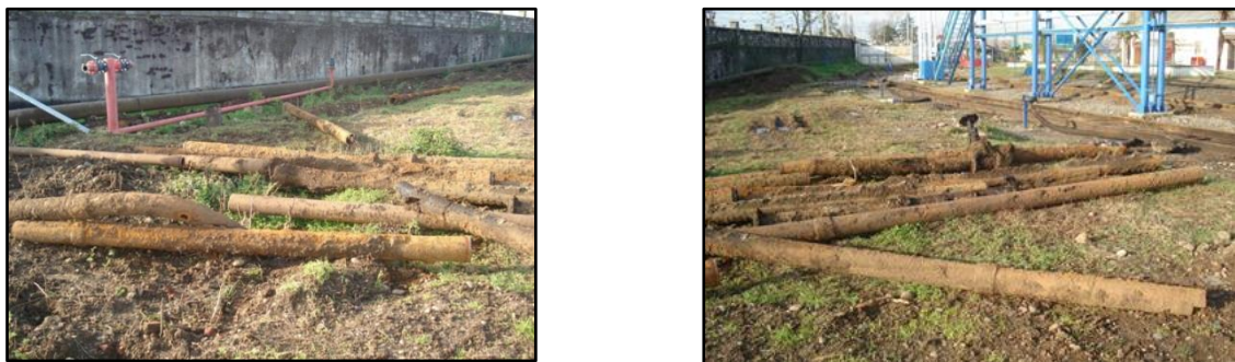
ძველი არაექსპლუატირებული მილების დემონტაჟი ნავთის უბანზე
