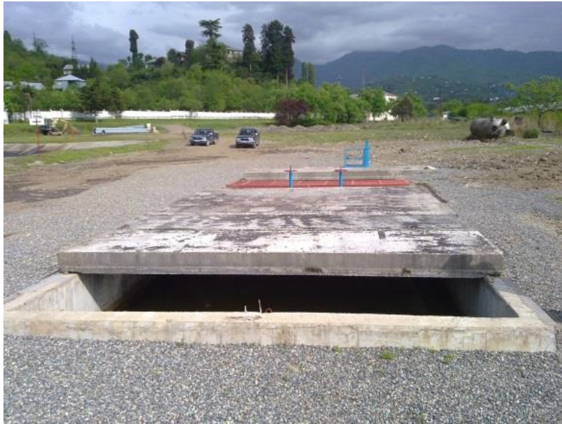
სურათი 7.2.3. „კაპრემუმი“-ს უბნის №2 ნავთობდამჭერის ხედი
