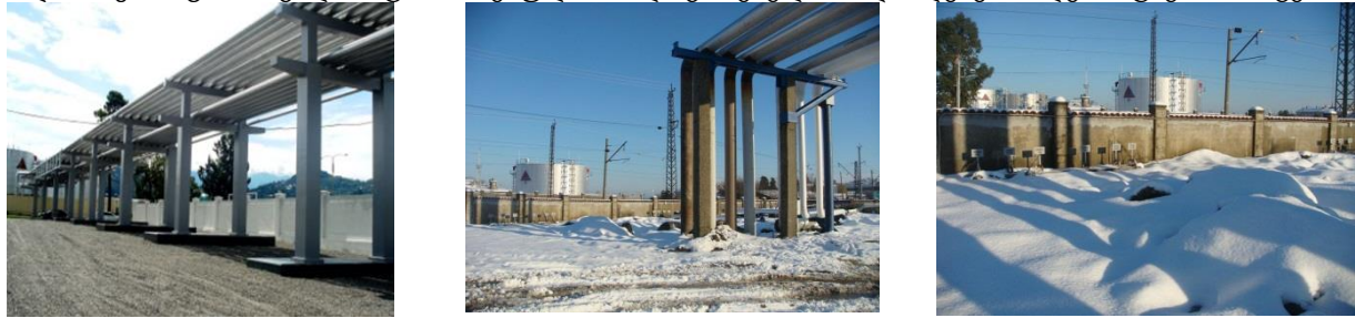
რეკონსტრუირებული მახლოკირებელი მილსადენების მიწისზედა ესტაკადა
