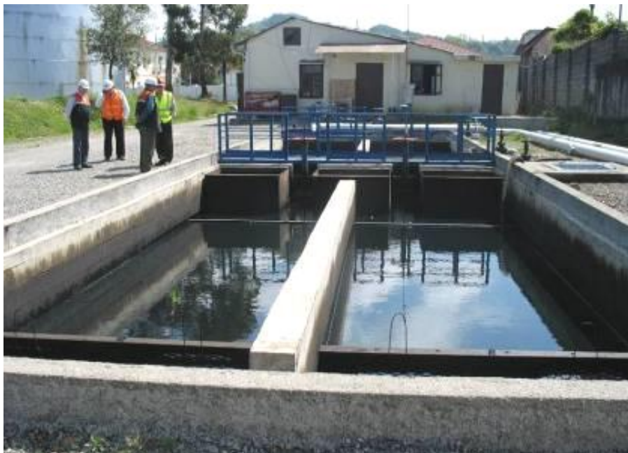
სურათი 7.1.3.2. დიზელის უბნის ნავთობდამჭერი
