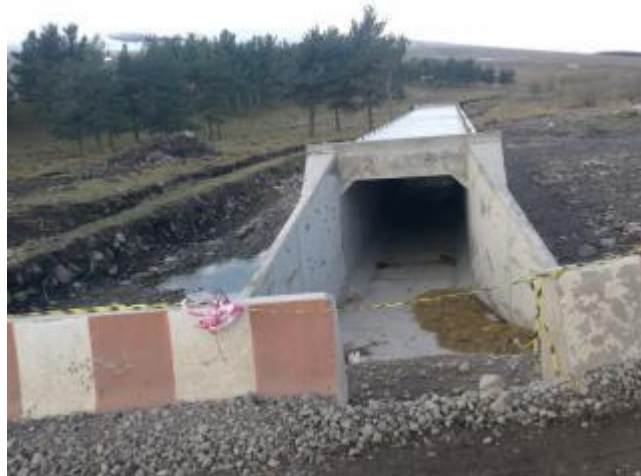
ნახაზი 28. ტიპური წყალმიმღები და წყალსაში ნაგებობა
