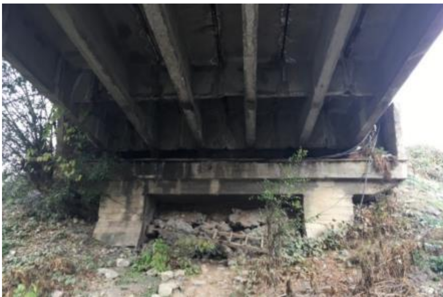
სურ. 3.2 - არსებული ხიდის ამორტიზირებული სტრუქტურა
