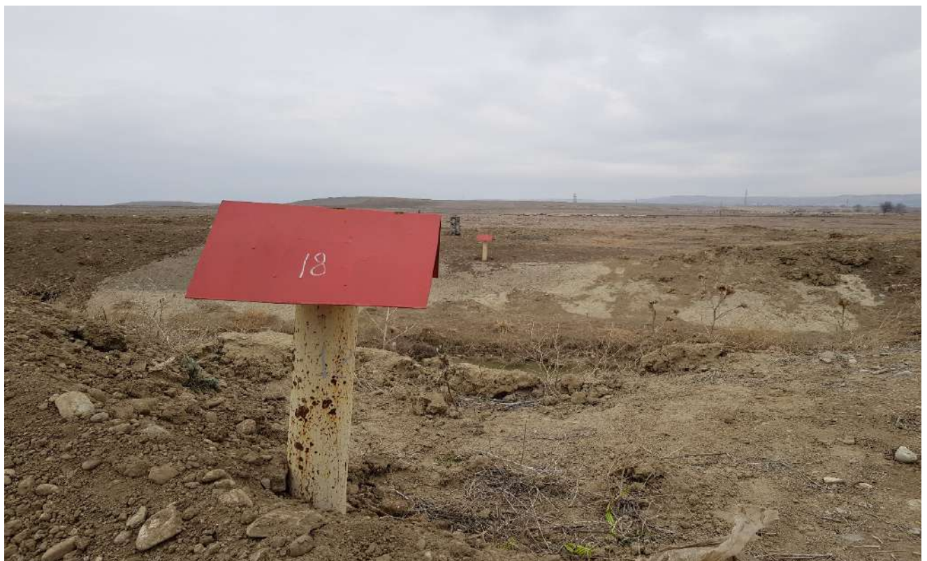
სურ 2.3.2.10 „საგურამო-ნავთლუღის“ მაგისტრალური გაზსადენის საინფორმაციო ბოძკინტები
