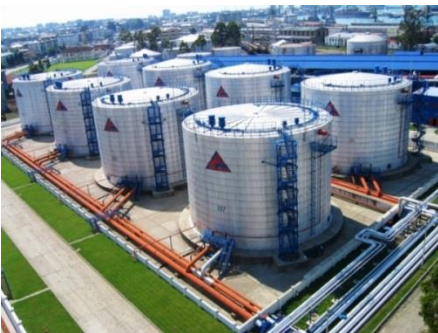
ნახაზი 3.3.1.3. №№224 +238 რეზერვუარების პარკი ძირითად ტერიტორიაზე
