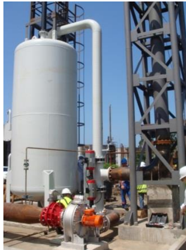
სურათი 3.4.3.2. აირგამწმენდი ფილტრი „ნედლი ნავთობისა და მაზუთის“ უბანში
