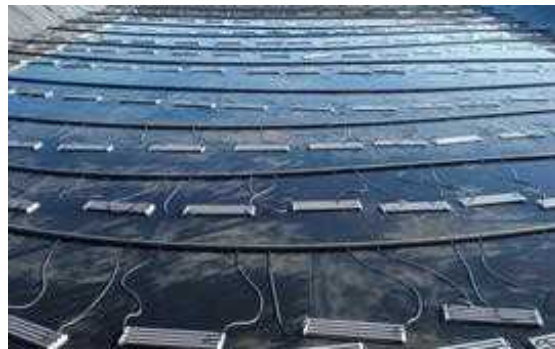
სურ. 9 - დასრულებული მიწური აუზის მშენებლობა დიფუზორის სისტემით (ნიმუში)
