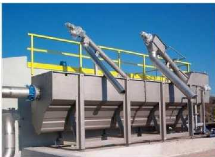
სურ. 7 - ტიპური კომბინირებული ცხაურის/ქვიშა/ცხიმის მოცილება
