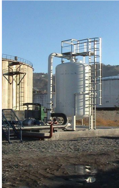
სურათი. 13.5.6. აირდამჭერი ფილტრი კაპრემუმის უბანში
