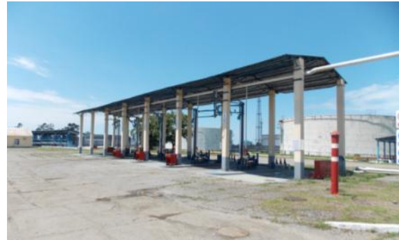
სურათი 5.7.2.1. ნავთობბაზის სარკინიგზო ესტაკადა და საავტომობილო ესტაკადა
