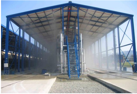
სურათი 12.2.1.3. ხანძარქრობის ქაფის ხსნარის მიწოდების სისტემები N2 სარკინიგზო ესტაკადაზე და სარეზერვუარო პარკში
