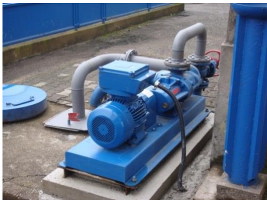
სურათი 7.1.6.1. ჩამდინარე წყლების მიმღები ჭები და გადასატუმბი დანადგარები №2 და №3 ნავმისადგომებზე
