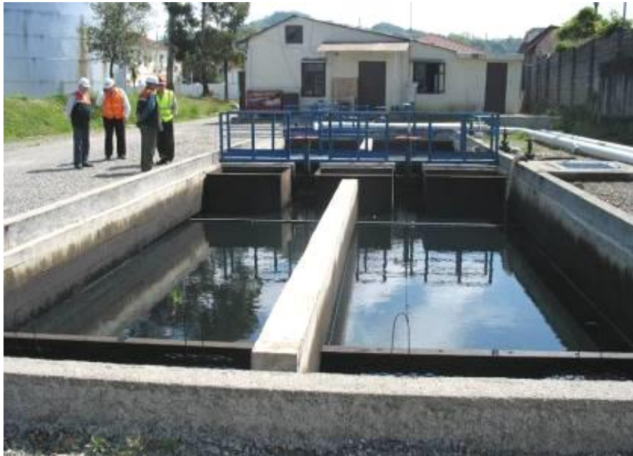
სურათი 7.1.3.2. დიზელის უბნის ნავთობდამჭერი
