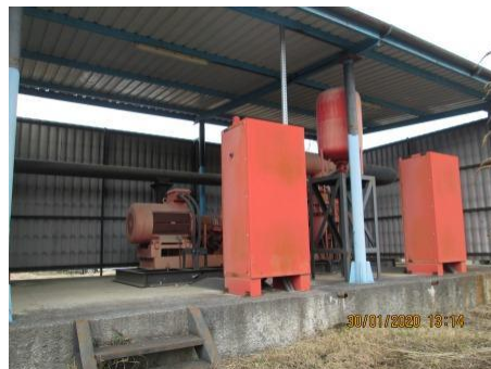
სურათი 12.2.1.2 . სახანძრო წყლის მიწოდების სატუმბო სადგურები თხევადი გაზის და კაპრემუმის უბნებზე
