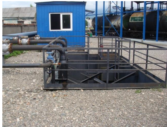
სურათი 7.4.2. #2 სარკინიგზო ესტაკადის სახურავიდან მონადენი წვიმის წყლების მდინარე ბარცხანაში გადასატუმბი სატუმბო სადგურის ხედი.
