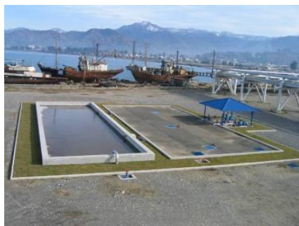
სურათი 7.1.6.4. ნავმისადგომების უბნის გამწმენდი ნაგებობების ლამშემკრები და ნავთობდამჭერი
