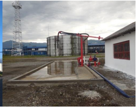
სურათი 5.4.4.3. ავტოცისტერნებში დიზელის საწვავის ჩასასხმელი დგარი
