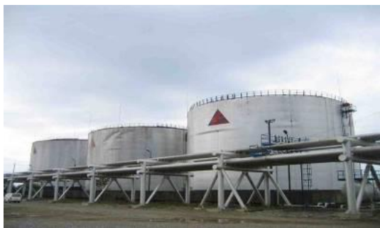
სურათი 7.1.6.3. ნავმისადგომების უბნის გამწმენდი ნაგებობების ბუფერული რეზერვუარები
