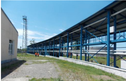
სურათი 5.7.2.1. ნავთობბაზის სარკინიგზო ესტაკადა და საავტომობილო ესტაკადა
