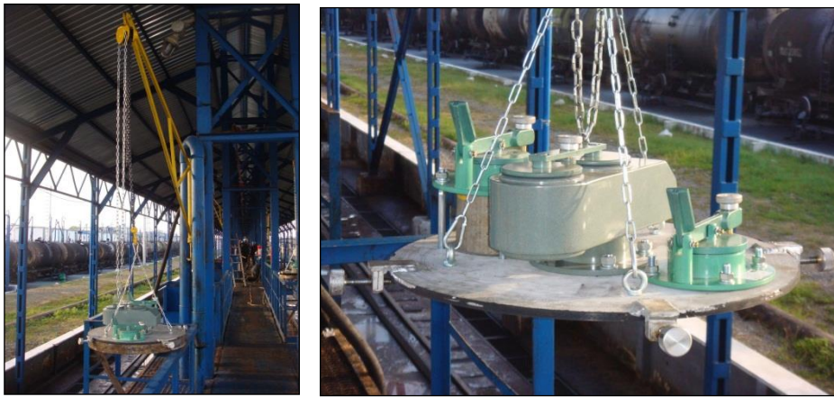
სურათი 16.11.1. ჰერმეტიზაციის სარქველები № 5 სარკინიგზო ესტაკადაზე
