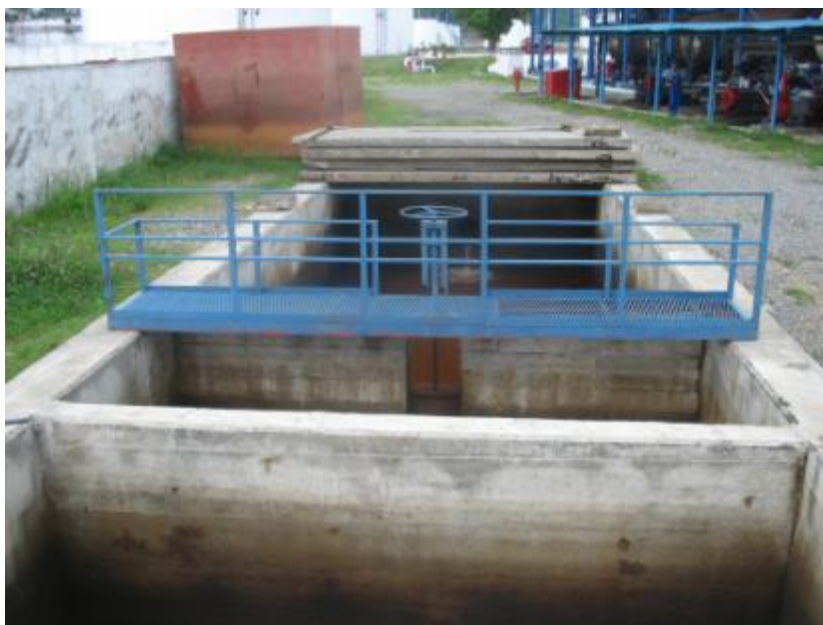
სურათი 7.6.1.3. ნავთობბაზის ლოკალური ნავთობდამჭერის ხედი
