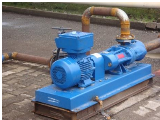
სურათი 7.1.6.1. ჩამდინარე წყლების მიმღები ჭები და გადასატუმბი დანადგარები №2 და №3 ნავმისადგომებზე
