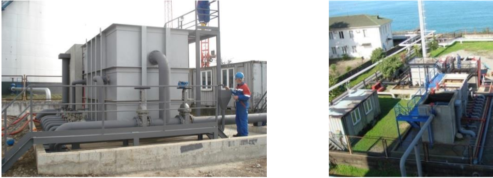
სურათი 7.1.6.5. ნავმისადგომების უბნის (ბალასტური და ლიალური წყლების) გამწმენდი ნაგებობებზე Facet Internationale-ს კოალესცენტური სეპარატორების ხედები
