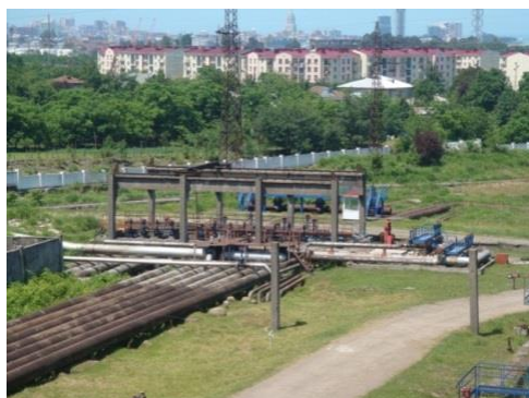
სურათი 5.6.4. ნედლი ნავთობის მიღების და გადატვირთვის სადგური - „კაპრეშუმის“ ტექნოლოგიური მილსადენები, მთავარი მანიფოლდი, და სატუმბო სადგურის შენობა
