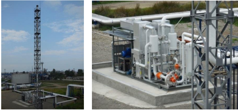
სურათი 13.5.9. აირგამწმენდი (აირების რეკუპერაციის) დანადგარი ნავთის უბანში
