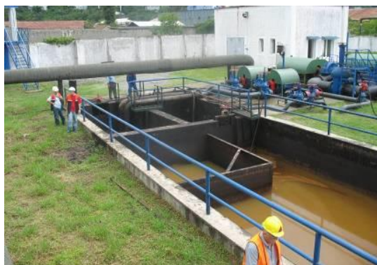
სურათი 7.6.2.2. ოთხკამერიანი ნავთობდამჭერი N2 (ხედი)
