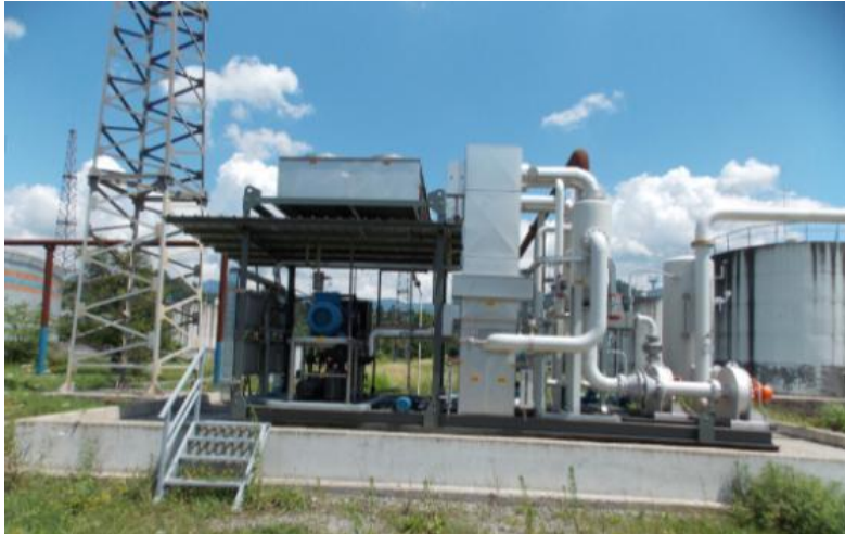
სურათი 13.5.7. ნავთობბაზის ნახშირწყალბადოვანი აირების სარეკუპერაციო დანადგარი
