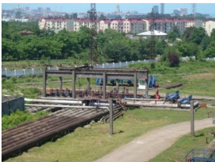
სურათი 3.5.3. ნედლი ნავთობის მიღების და გადატვირთვის სადგური - „კაპრემუმის“ ტექნოლოგიური მილსადენები, მთავარი მანიფოლდი, და სატუმბო სადგურის შენობა
