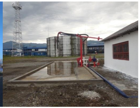
სურათი 3.3.4. ავტოცისტერნებში დიზელის საწვავის ჩასასხმელი დგარი
