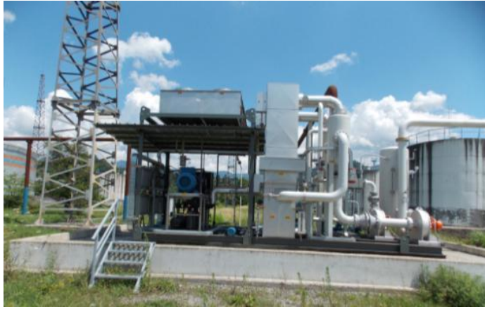
სურათი 3.16.2.5. ნავთობბაზის ნახშირწყალბადოვანი აირების სარეკუპერაციო დანადგარი
