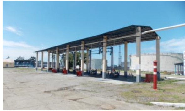
სურათი 3.6.2. ნავთობბაზის სარკინიგზო ესტაკადა და საავტომობილო ესტაკადა
