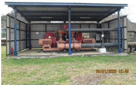
სურათი 3.16.2. სახანძრო წყლის მიწოდების სატუმბო სადგურები თხევადი გაზის და კაპრემუმის უბნებზე
