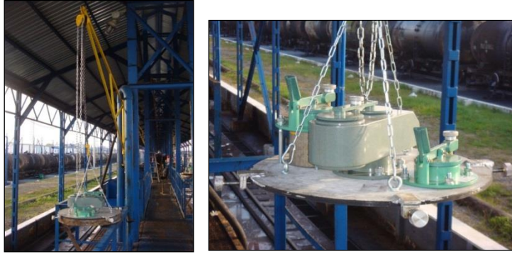
სურათი 3.16.2.1. ჰერმეტიზაციის სარქველები № 5 სარკინიგზო ესტაკადაზე
