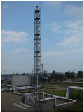
სურათი 3.16.2.6. აირგამწმენდი (აირების რეკუპერაციის) დანადგარი ნავთის უბანში
