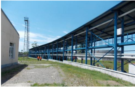
სურათი 3.6.2. ნავთობბაზის სარკინიგზო ესტაკადა და საავტომობილო ესტაკადა
