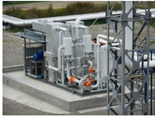
სურათი 3.16.2.6. აირგამწმენდი (აირების რეკუპერაციის) დანადგარი ნავთის უბანში
