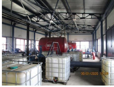
სურათი 3.16.4. ხანძარქრობის ქაფის და გასაგრილებელი წყლის ავტომატიზირებული სატუმბო სადგური
