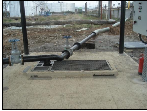
სურათი 5.5.3. ორი 20 000 მ 3 ტევადობის ნავთობის რეზერვუარების პარკის პირობითად სუფთა წვიმის წყლების გაყვანის სატუმბო სადგური და საწნეო მილსადენი
