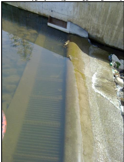
ნახ. 4.2.1. წყალმიმღები ნაგებობები მდინარე კუბასწყალზე
