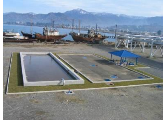
სურათი 5.1.6.4. ნავმისადგომების უბნის (ბალასტური და ლიალური წყლების) გამწმენდი ნაგებობების ლამმემკრები და ნავთობდამკერი
