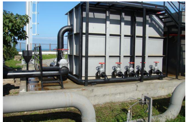
სურათი 5.1.6. 7. კოალესცენტური სეპარატორი და გამყვან მილზე დამონტაჟებული ნავთობის ნახშირწყალბადების კონცენტრაციის პერმანენტულად გამზომი ხელსაწყო
