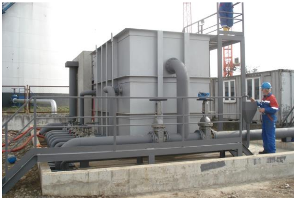
სურათი 5.1.6.5. ნავმისადგომების უბნის (ბალასტური და ლიალური წყლების) გამწმენდი ნაგებობებზე Facet Internationale-ს კოალესცენტური სეპარატორების ხედები
