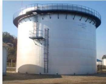
სურათი 3.2.1.4. გნა-ს მიღების და გადატვირთვის სადგურის არსებული ნავთობდამჭერი და 3000 მ3 ტევადობის სახანძრო რეზერვუარი
