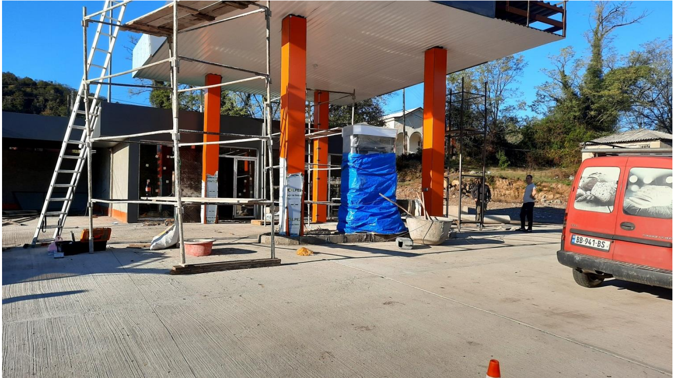
სურათი 2. გამანაწილებელი აპარატურის მონტაჟი
