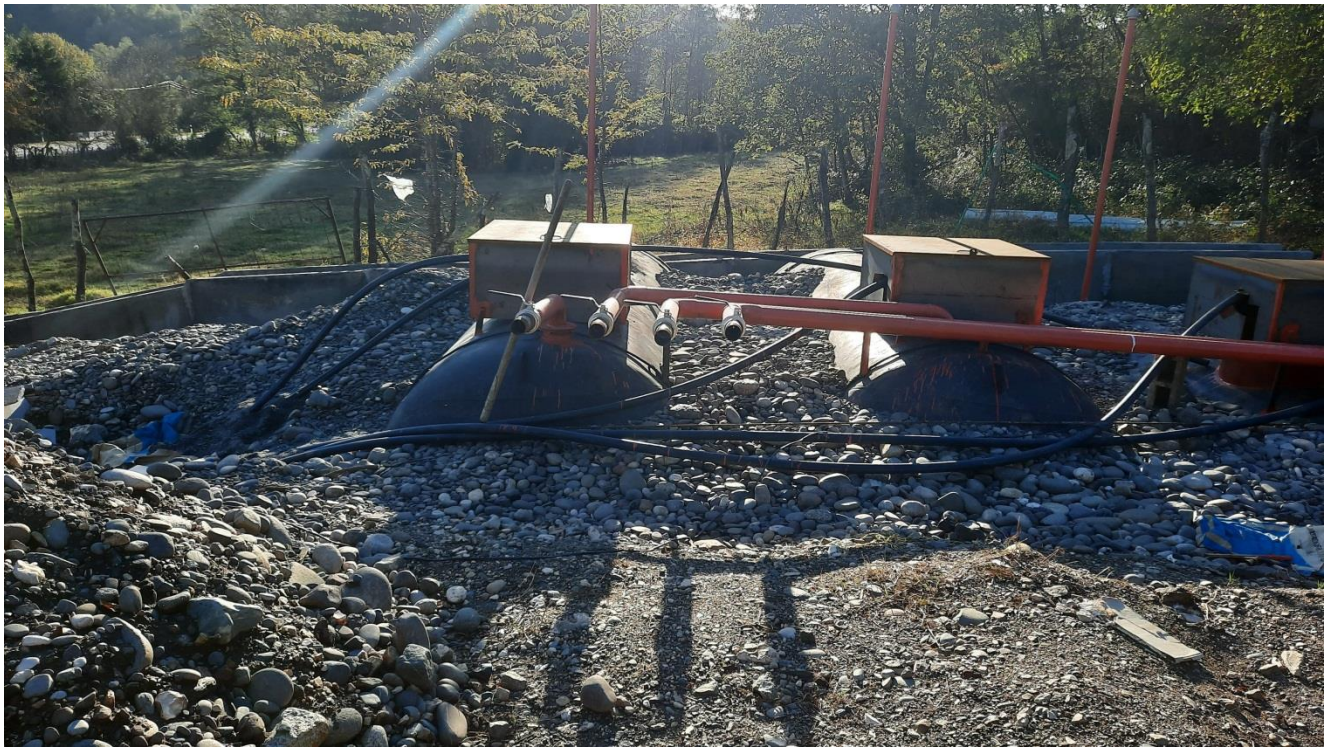
სურათი 3. სარეზერვუარო პარკის მონტაჟის პროცესი
