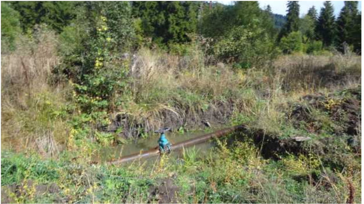
სურათი №20. არსებული გრუნტის გზის და საპროექტო სადაწნეო მილსადენის პარალელურად გადის 219 მმ-იანი დიამეტრის მეტალის მილების მეშვეობით წყალსადენის ხაზი სოფ. ცხრაწყაროდან სოფ. ტბამდე.
