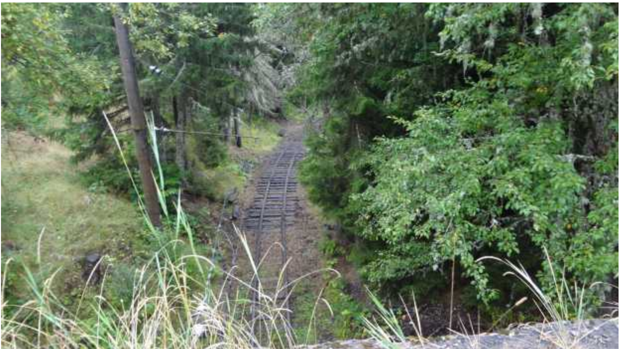
სურათი №11. 7 მ სიმაღლის რკინა-ბეტონის საავტომობილო გადასასვლელი ხიდი რკინიგზის მაგისტრალის ზემოთ. ხიდი გაყვანილია სპეციალურად მოწყობილ ყრილზე ორივე მხრიდან - ეგზ ხაზის პარალელურად. ხიდიდან ~70 მ-ში (სურათის უკანა პლანზე) დასავლეთით რკინიგზის ვაკისის ქვეშ გვირაბის მეშვეობით გაივლის საპროექტო სადაწნეო მილსადენის ხაზი.
