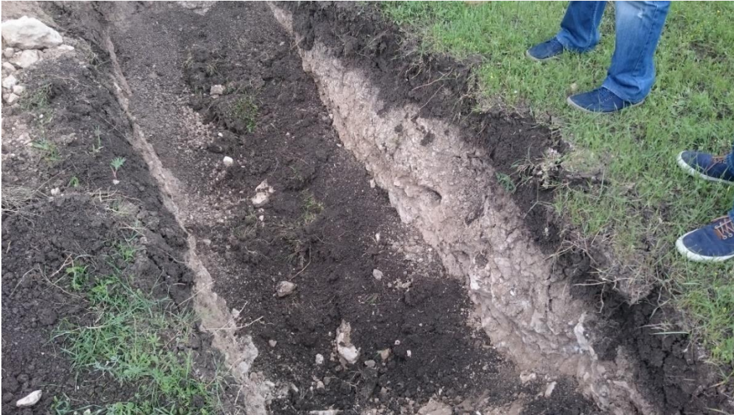
საკვლევი შურფი ლოკაციაზე
