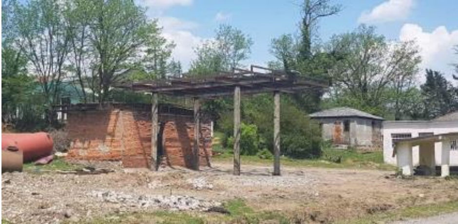
სურათი N10 საპროექტო ტერიტორია მშენებლობის დაწყებამდე
