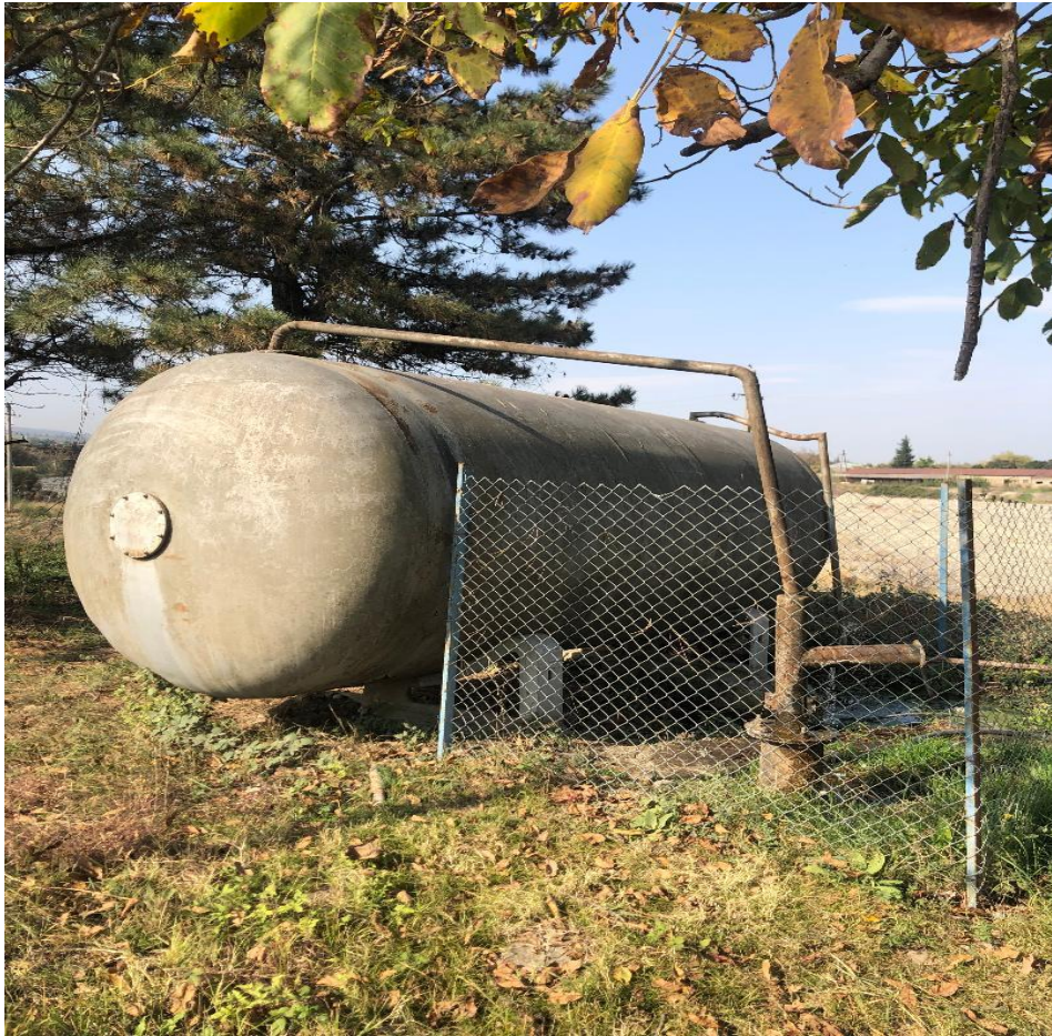
სურ. N 12 - ობიექტის ტერიტორიის მიმდებარედ მოწყობილი წყლის სამარაგო რეზერვუარი და წყლის ჭაბურღილი
