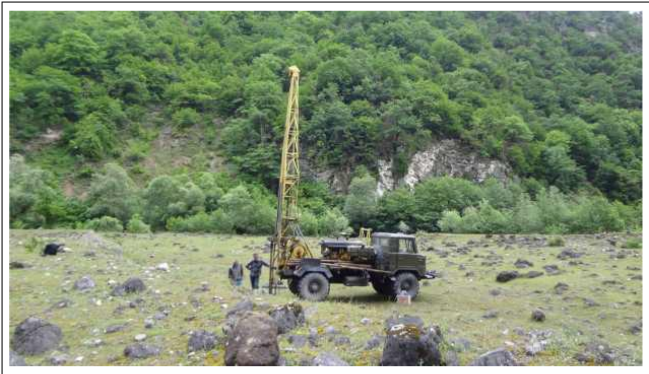
№ 23 ჭაბურღილის ბურღვის პროცესი საპროექტო ჰესის ცენტრალურ ნაწილში. უკანა პლანზე მოჩანს მდ. ჯონოულის ხეობის მარცხენა ქვედა ნაწილი, ცარცული (K) ასაკის კირქვების გამოსავალებით
