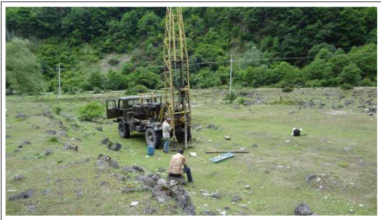
№ 25 ჭაბურღილის ბურღვის პროცესი საპროექტო ჰესის ტერიტორიაზე – მდ. ჯონოულის მაღალი ჭალის ტერასაზე. ხედი სამხრეთ-დასავლეთით უკანა პლანზე მოჩანს ელექტროგადამცემი ხაზი და გაუმჯობესებული გრუნტის გზის მონაკვეთი.
