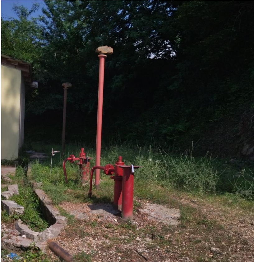
სურათი 2. არსებული ავზების თავმორთულობა
