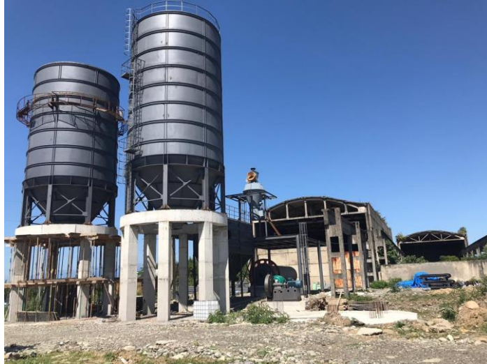
სურათი 3.4.7. ცემენტის სილოსები, ნახევრად აშენებულ მდგომარეობაში
