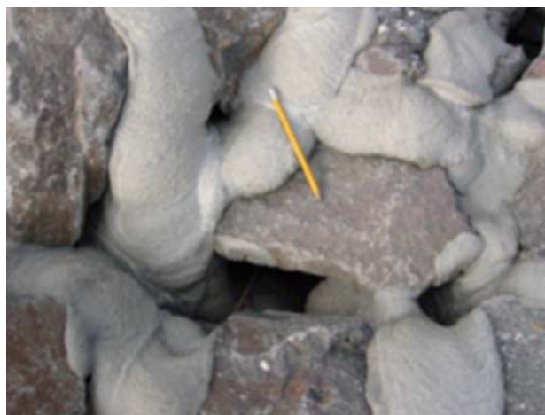
სურათი 3.2.3.1. ნაწილობრივ ცემენტირებული ქვაყრილის მაგალითი
