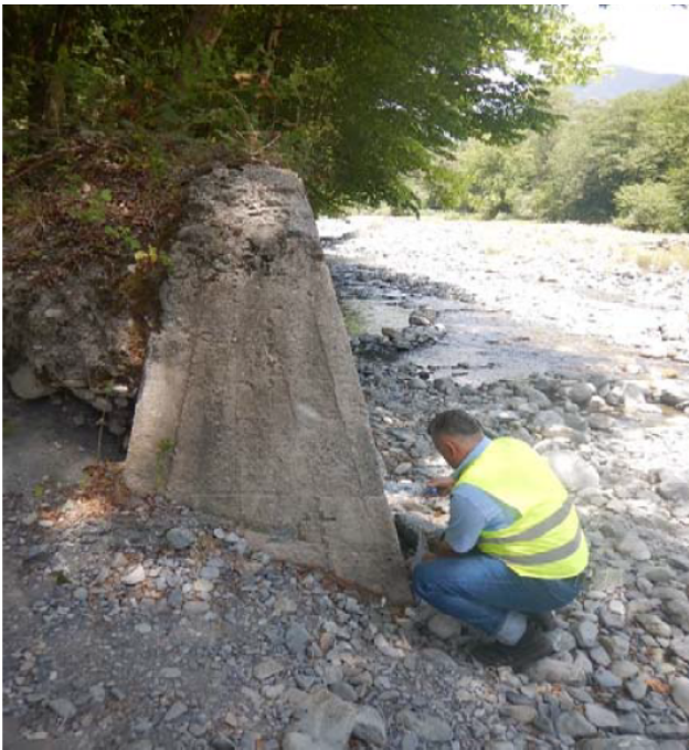
სურათები 3.1.1. ბეტონის კედლის მორღვეული ნაგებობები მდინარის გასწვრივ
