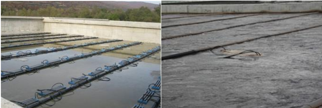
სურ. 9 - მარცხენა: აშენებული ავზი დიფუზორის სისტემით. მარჯვენა: აერატორი სარემონტო მდგომარეობაში (ნიმუში)
