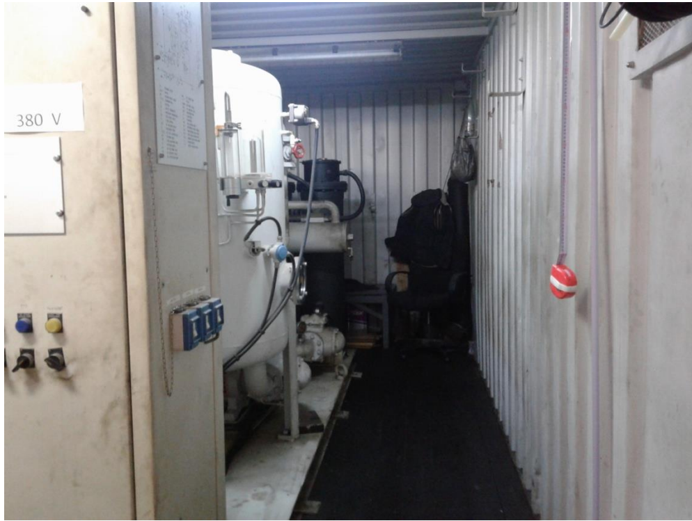
სურ. 3.1.4. დეგაზაცია - შრობა -ფილტრაციის დანადგარი DOV 5002/P
