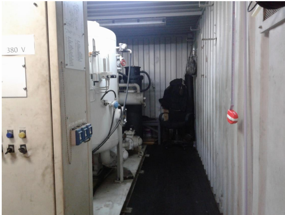
სურ. 3.1.4. დეგაზაცია - შრობა -ფილტრაციის დანადგარი DOV 5002/P
