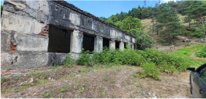
(გ) ტერიტორიაზე არსებული შენობა ნაგებობები
